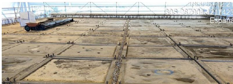
Vertido inicial de grava
