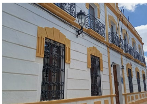
Vista exterior del edificio
