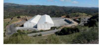
Celda 29 de residuos de muy baja actividad de El Cabril
