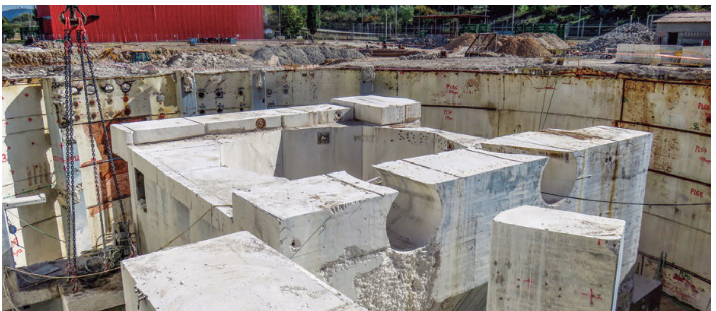
Trabajos de despiece en el fondo de la vasija del reactor
