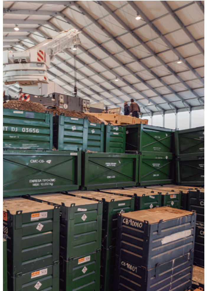
Diposición de los residuos de muy baja actividad en la celda de almacenamiento.
