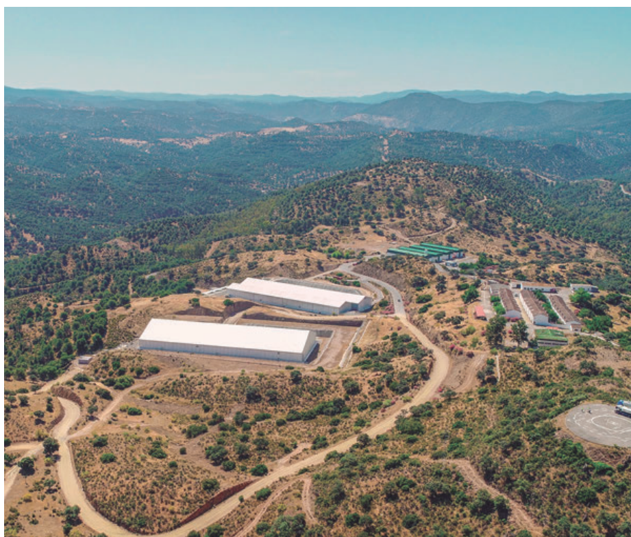
Vista aérea de las estructuras para residuos de muy baja actividad.
