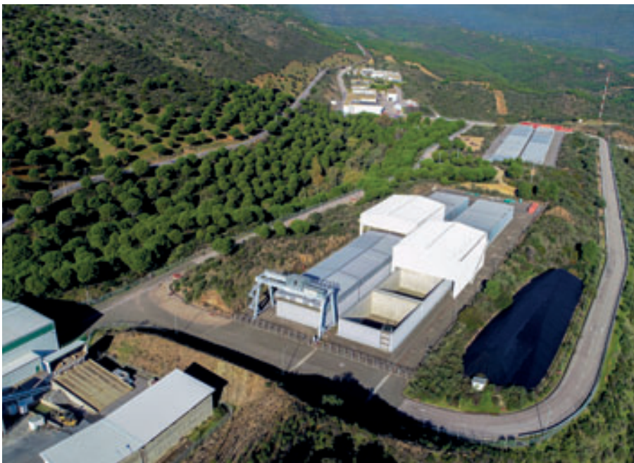
Vista aérea de las instalaciones de El Cabril.
