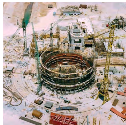
Grandes grúas y excavadoras vuelven, años después, a la primera central nuclear de España para acometer su desmantelamiento definitivo. Arriba, imagen de 1967 durante el proceso de construcción de la central. / NATURGY A la derecha, durante los trabajos de demolición en 2020.
