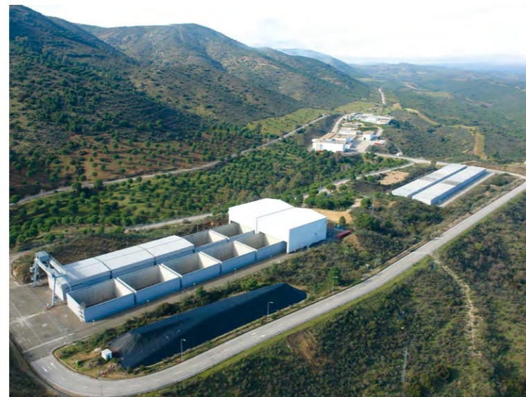
Vista general de las plataformas de almacenamiento de RBMA de El Cabril. / ARCHIVO ENRESA
