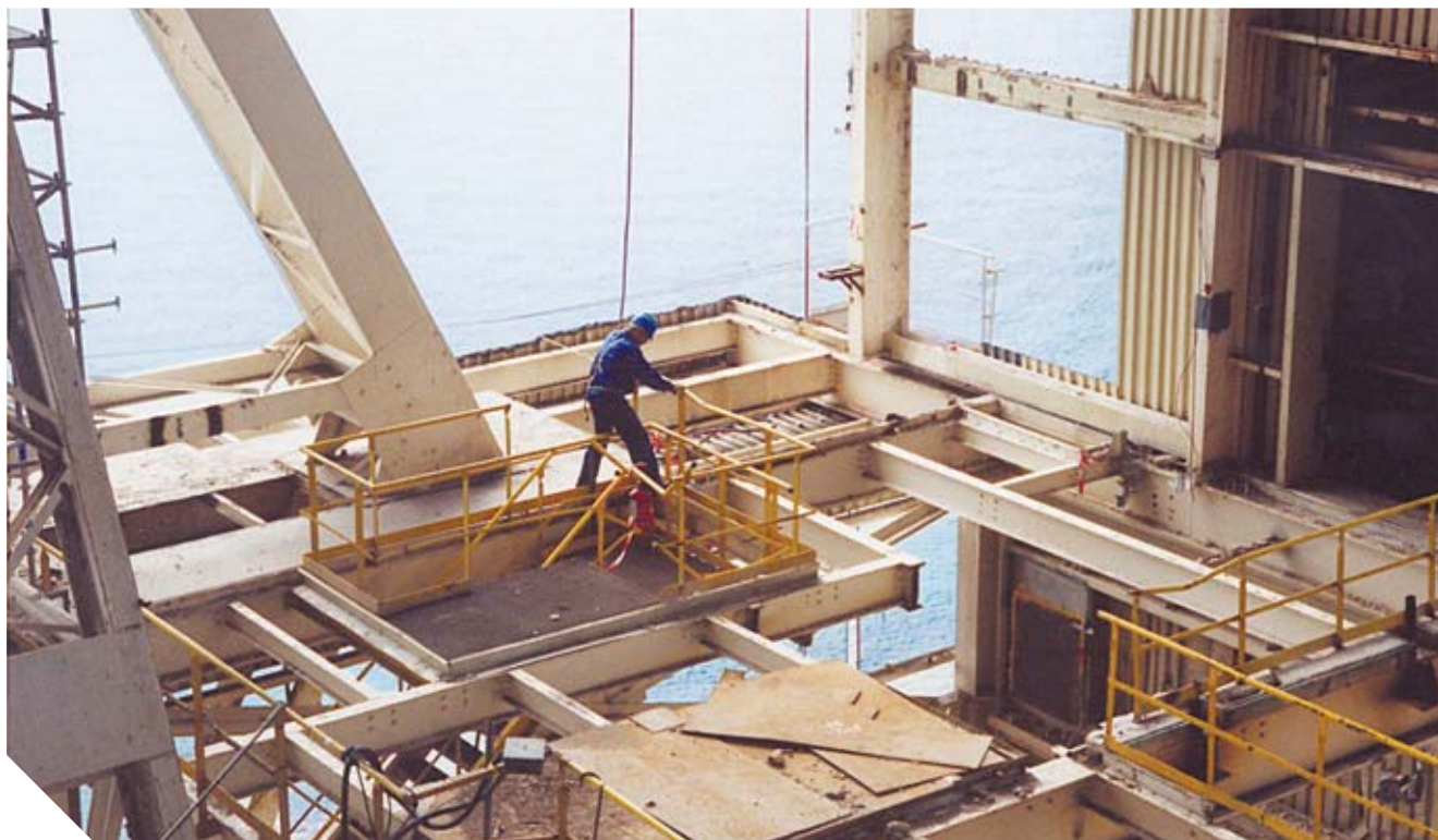
DESMONTAJE DE LA NAVE DEL REACTOR
