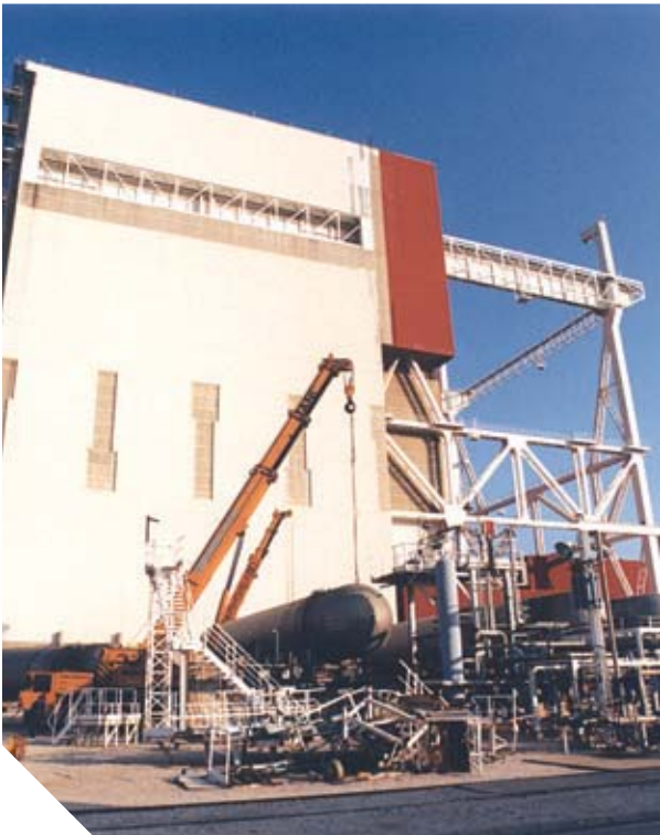
NIVEL 1 DE DESMANTELAMIENTO. RETIRADA DE LOS DEPÓSITOS DE CO 2
