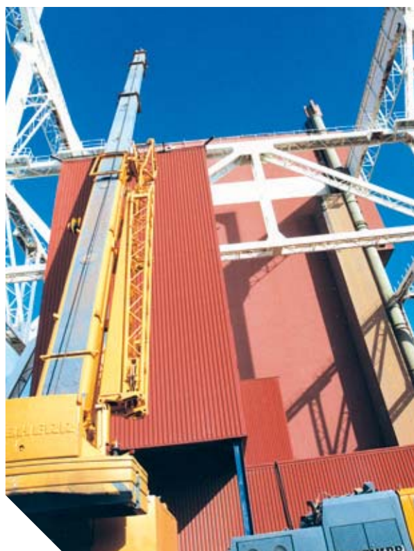
MANIOBRA DE EXTRACCIÓN DEL PUENTE GRÚA DE LA NAVE DE PISCINAS
