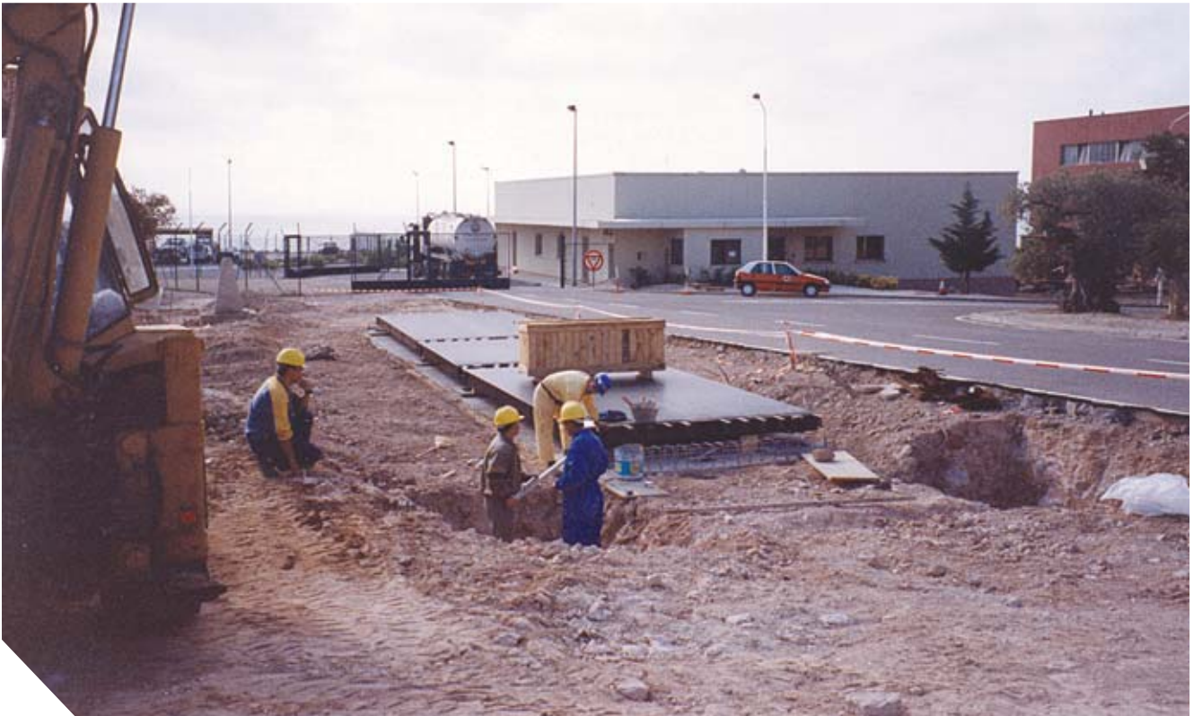
CONSTRUCCIÓN DEL PÓRTICO DE CONTROL RADIOLÓGICO PARA CAMIONES
