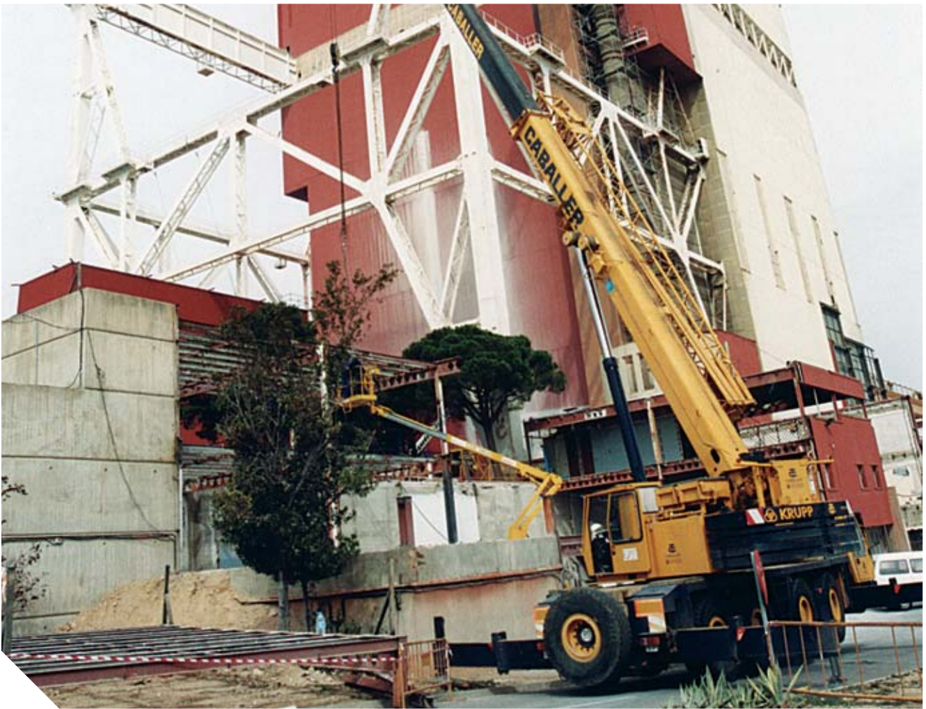
DESMONTAJE DEL EDIFICIO DE ADMINISTRACIÓN
