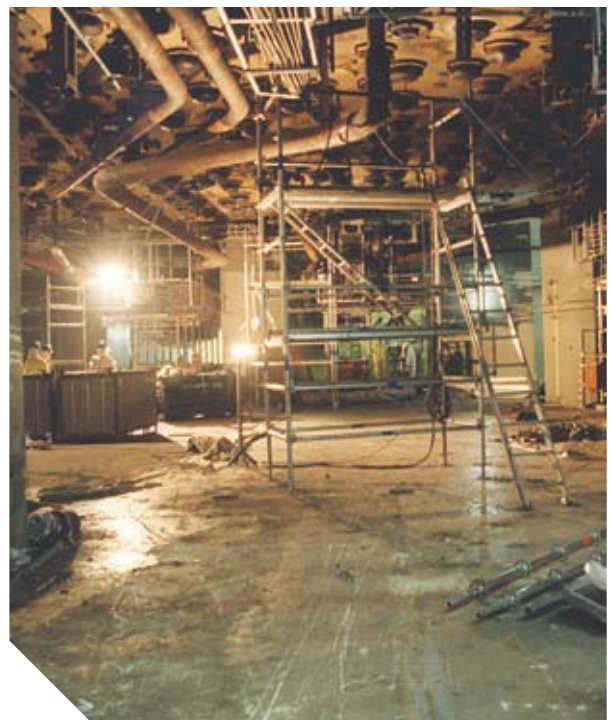
DESMONTAJE DE EQUIPOS Y SISTEMAS EN LA CAVA DEL REACTOR
