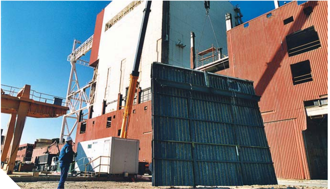
FASE FINAL DEL DESMONTAJE DEL EDIFICIO DE AUXILIARES ELÉCTRICOS
