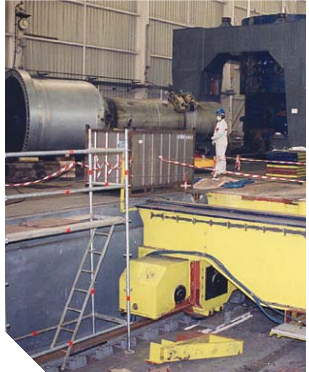
DESMANTELAMIENTO DEL DISPOSITIVO PRINCIPAL DE MANUTENCIÓN
