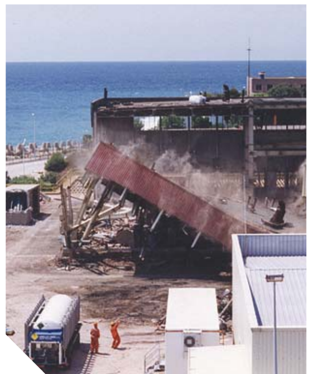
DEMOLICIÓN DE LA CENTRAL AUXILIAR
