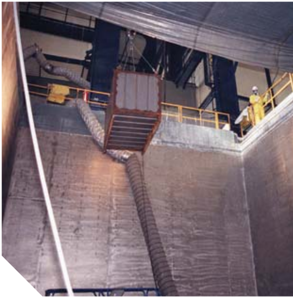
RETIRADA DEL REVESTIMIENTO METÁLICO EN LA NAVE DE PISCINAS
