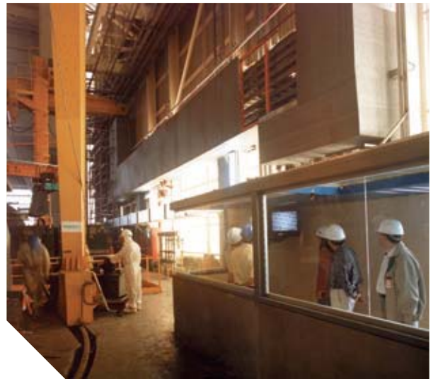
MIRADOR PARA VISITAS UBICADO EN LA COTA +16 DE LA NAVE DEL REACTOR
