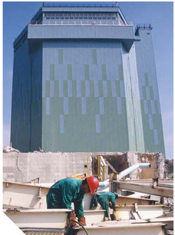
CORTE DE MATERIALES PROCEDENTES DEL DESMONTAJE DE LA NAVE DEL REACTOR
