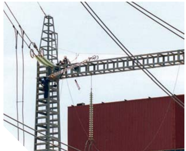
TRABAJOS DE DESMONTAJE DE LAS TORRES DE ALTA TENSIÓN.
