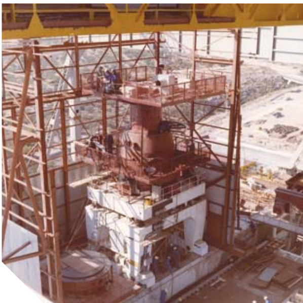
CONSTRUCCIÓN DEL DISPOSITIVO PRINCIPAL DE MANUTENCIÓN (DPM). AÑO 1970
