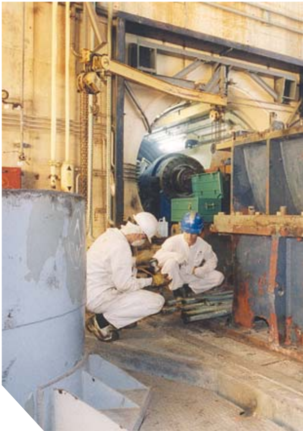
DESMONTAJE DE UNA DE LAS TURBOSPLANTES DEL CAJÓN DEL REACTOR
