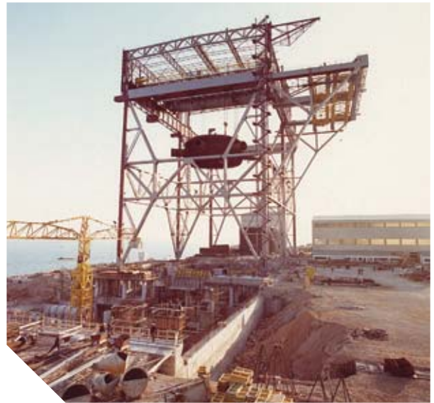
CONSTRUCCIÓN DEL REACTOR DE VANDELLÓS I. AÑO 1969
