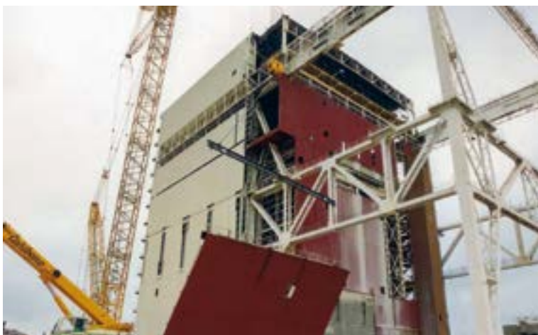
Desmontaje de la estructura de protección del cajón del reactor en junio de 2002.
