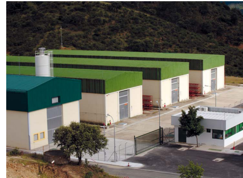
Vista de los antiguos módulos de almacenamiento. En primer término, el Edificio Tecnológico de residuos de muy baja actividad.
