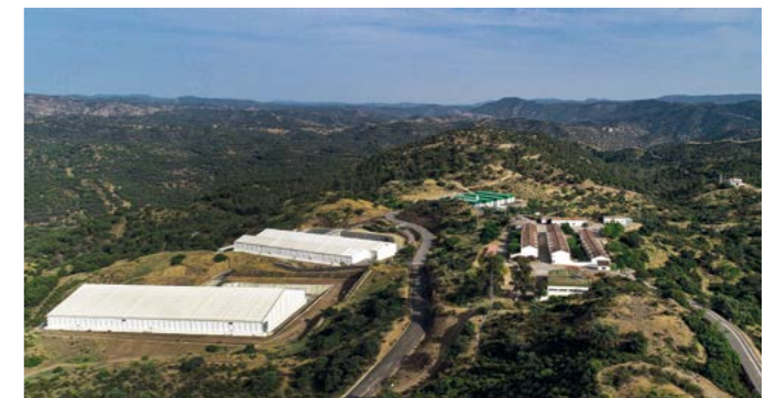
Arriba, obras de construcción de la Celda 29 de la instalación complementaria de RBBA. Abajo, vista aérea de las celdas de residuos de muy baja actividad, el poblado de Santa Bárbara y los antiguos módulos de almacenamiento.
