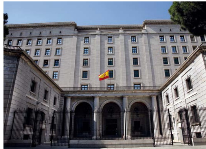
Sede del MITECO en Madrid.
