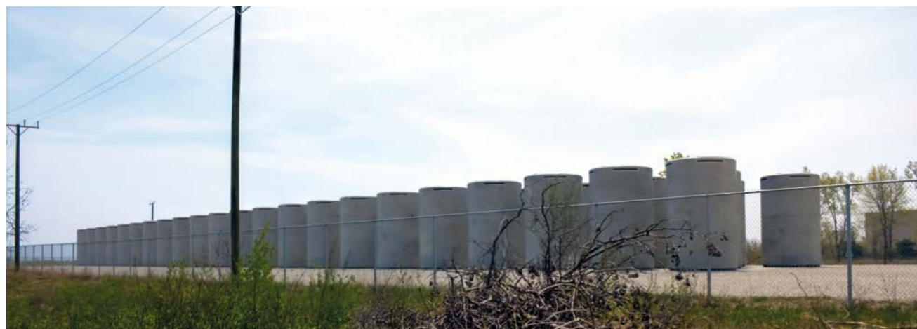
Arriba, contenedores de combustible gastado de la central nuclear estadounidense Zion en Illinois. Debajo, carga de un contenedor Hi-Storm en la C.N. de Ascó.
