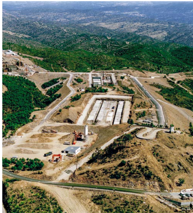
Vista aérea de las obras de construcción de las instalaciones.
