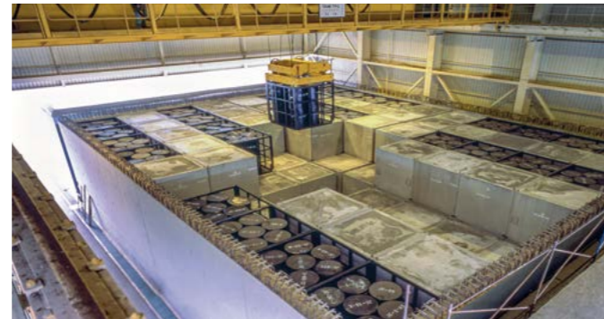
Interior de una celda de almacenamiento de RBMA. Abajo, vista de una plataforma de almacenamiento
