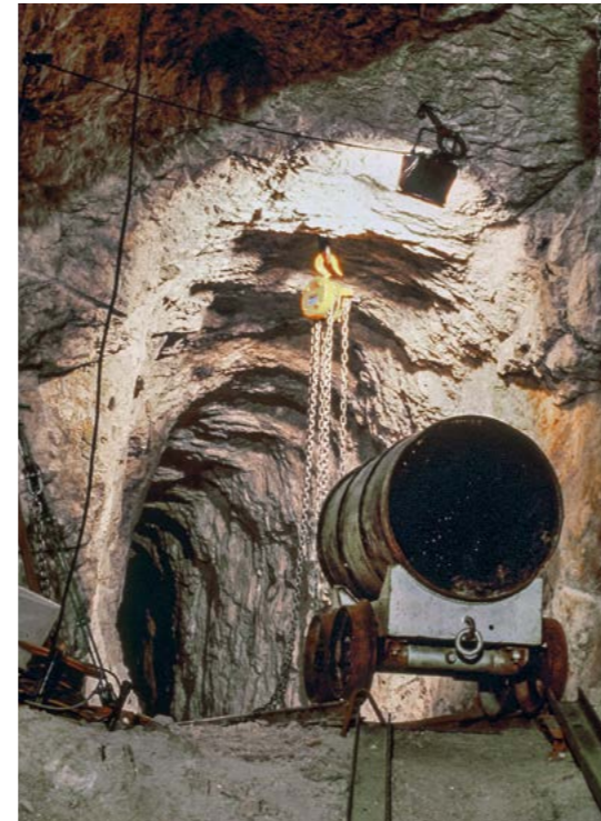
Una de las primeras actuaciones fue la extracción de los residuos de la Mina Beta.
