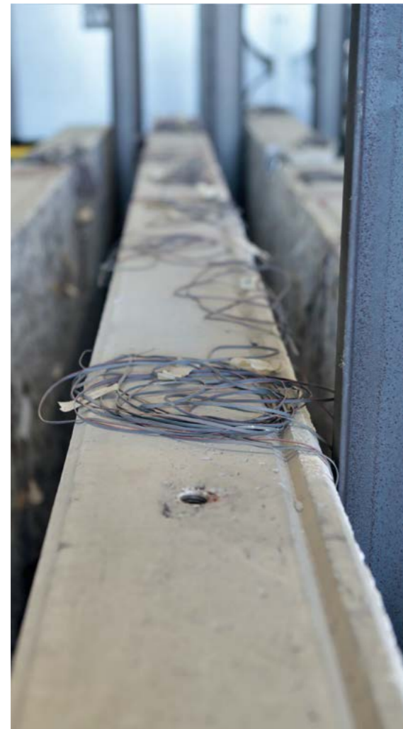
Detalle de vigas y piezas de hormigón de grandes dimensiones "monitorizadas". Sala de pruebas del CITEEC. A Coruña.
