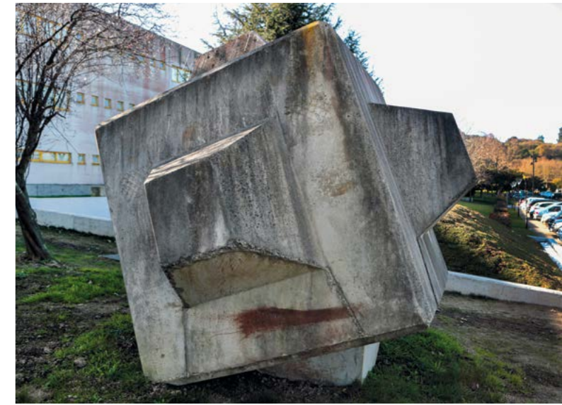
Bloque de hormigón fabricado para su uso en costas. ETS de Ingeniería de Caminos, Canales y Puertos de A Coruña.
