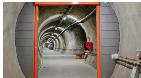
Laboratorios subterráneos de Grimsel (izquierda) y Mont Terri (arriba), donde se investiga el comportamiento del combustible gastado en formaciones de roca granítica y suelo arcilloso, respectivamente.
