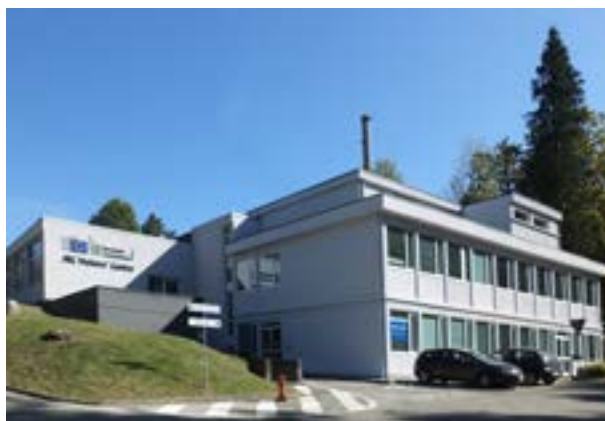
Centro de visitas del Laboratorio de Ispra (Italia).
