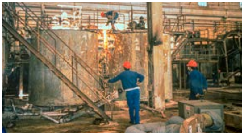
Trabajos de segmentación de depósitos en la FUA durante el desmantelamiento.
