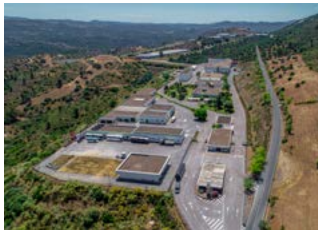
El Cabril - Vista general de la instalación. Archivo Enresa.
