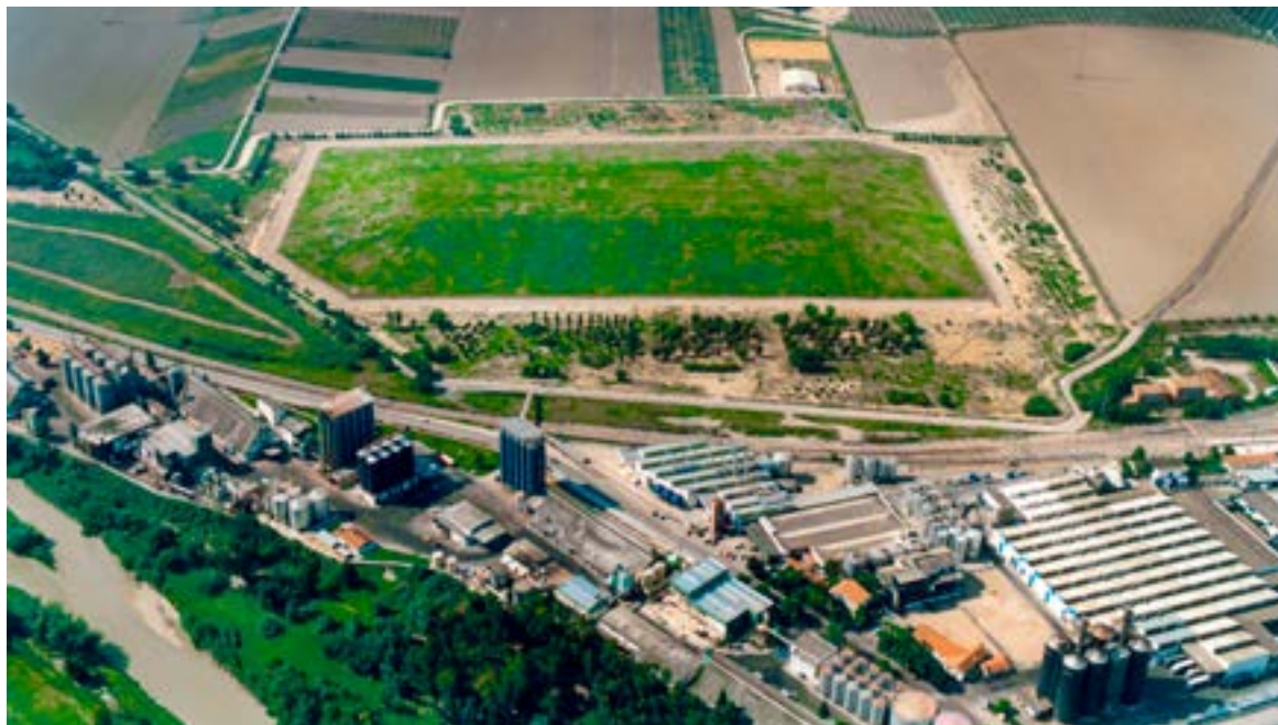
Vista Aérea de la instalación tras el proyecto de desmantelamiento y clausura.
