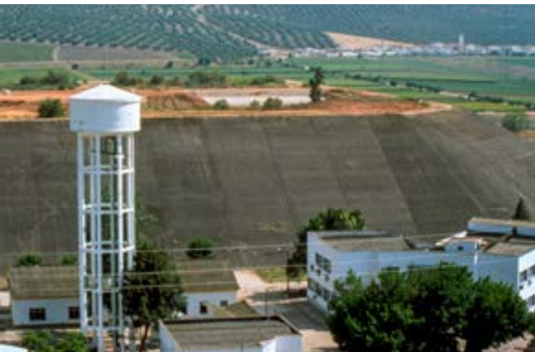
Edificios de la fábrica antes de su demolición. Detrás, el dique de estériles con cobertura de asfalto.
