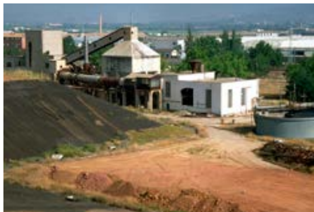
Vista parcial de las viejas instalaciones para la fabricación de concentrado de uranio, poco antes de su desmantelamiento.
