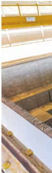
Almacenamiento de un contenedor 15-20 en una celda.
