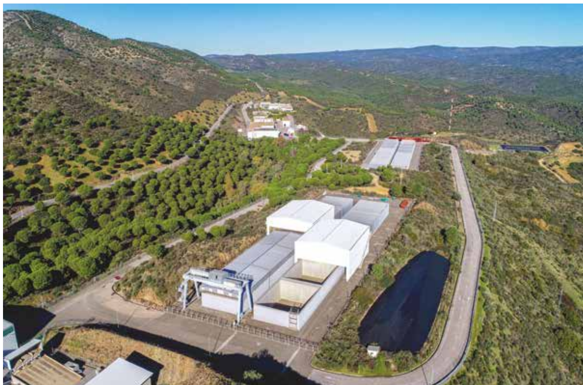
Vista general del Centro de Almacenamiento de El Cabril.
