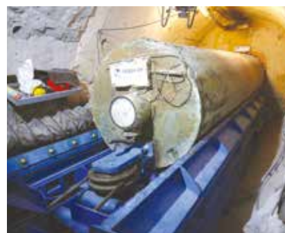
FIGURA 4. Dos momentos de la extracción del calentador 2 que simulaba al contenedor de residuos en el ensayo FEBEX de Grimsel (diámetro de la galería: 2,3 m)
