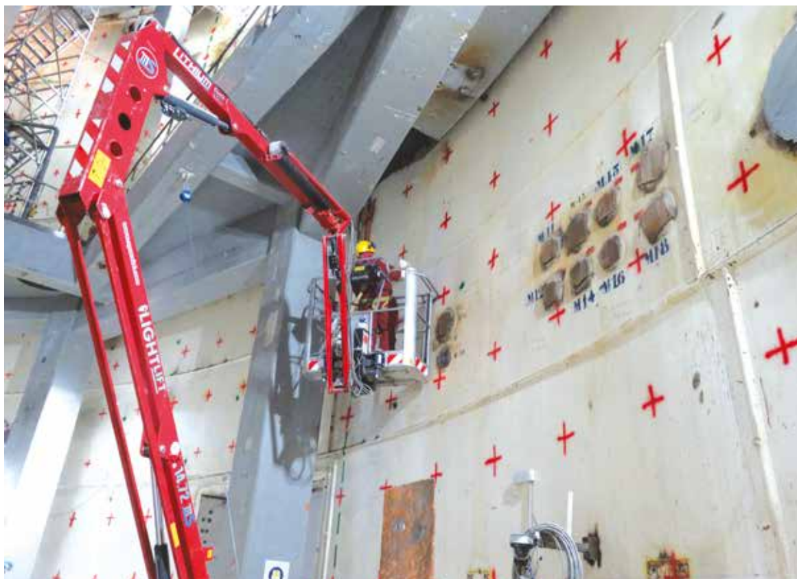
CARACTERIZANDO SE PUEDE SABER EL ESTADO RADIOLÓGICO EN EL QUE SE ENCUENTRA UNA PARED, UN SUELO O UN MATERIAL.
