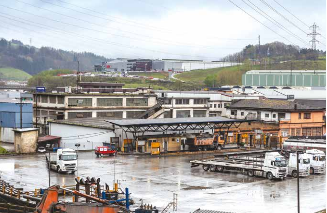
Fabrica siderúrgica de ArcelorMittal Guipúzcoa, en Olaberriá, (San Sebastián).
