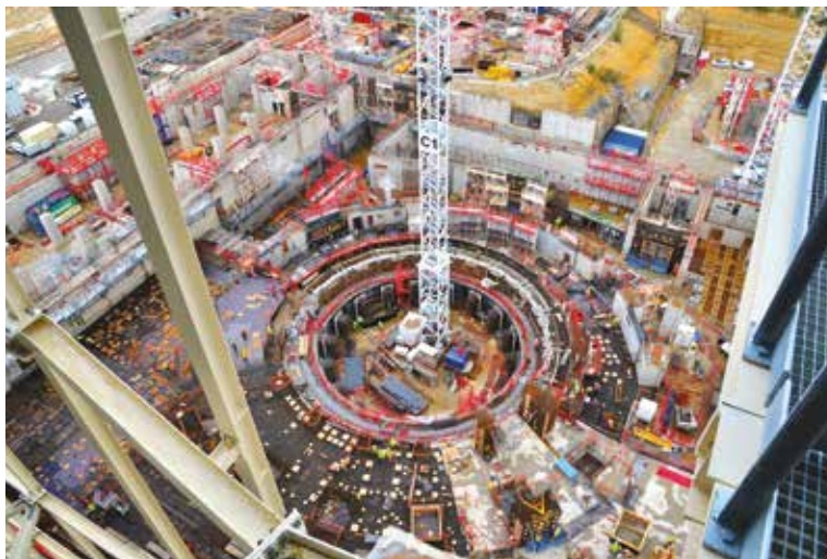
Vista aérea de la construcción del Tokamak del ITER (julio de 2016).
