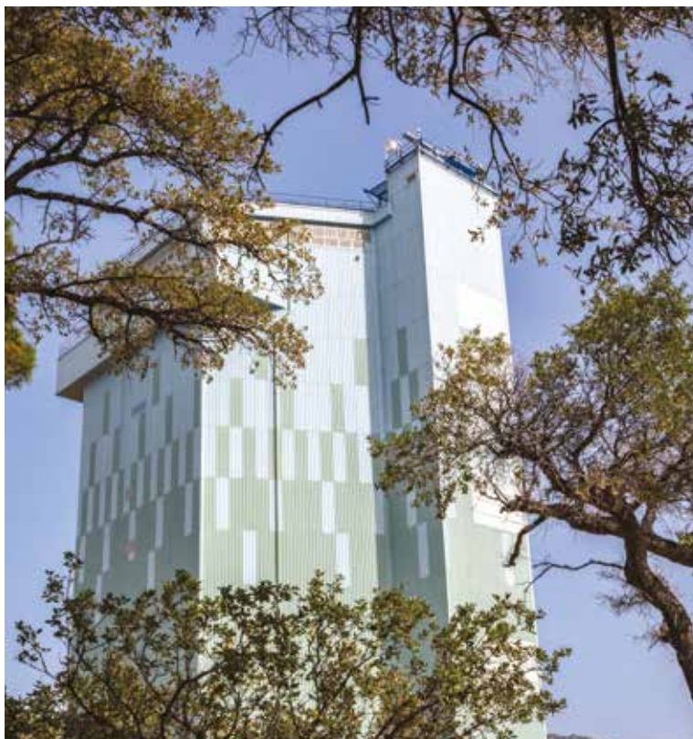
Estado actual del reactor durante el periodo de latencia .
