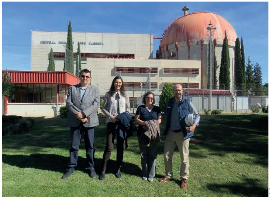
La delegación croata del Fund for Financing the Decommissioning of Krsko NPP a las puertas de Zorita junto a personal de Enresa en la instalación.
