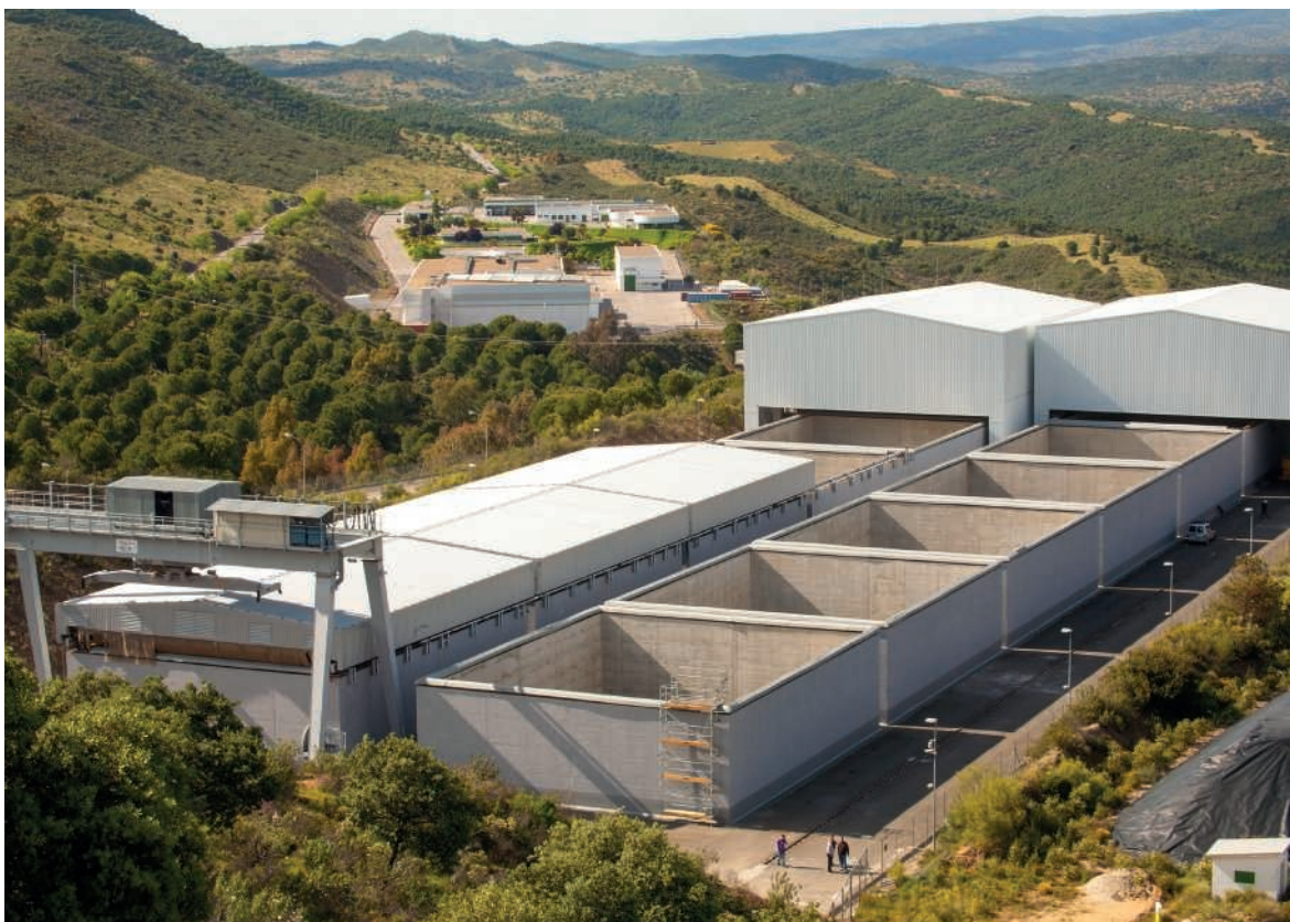
Vista parcial de las instalaciones de El Cabril.
