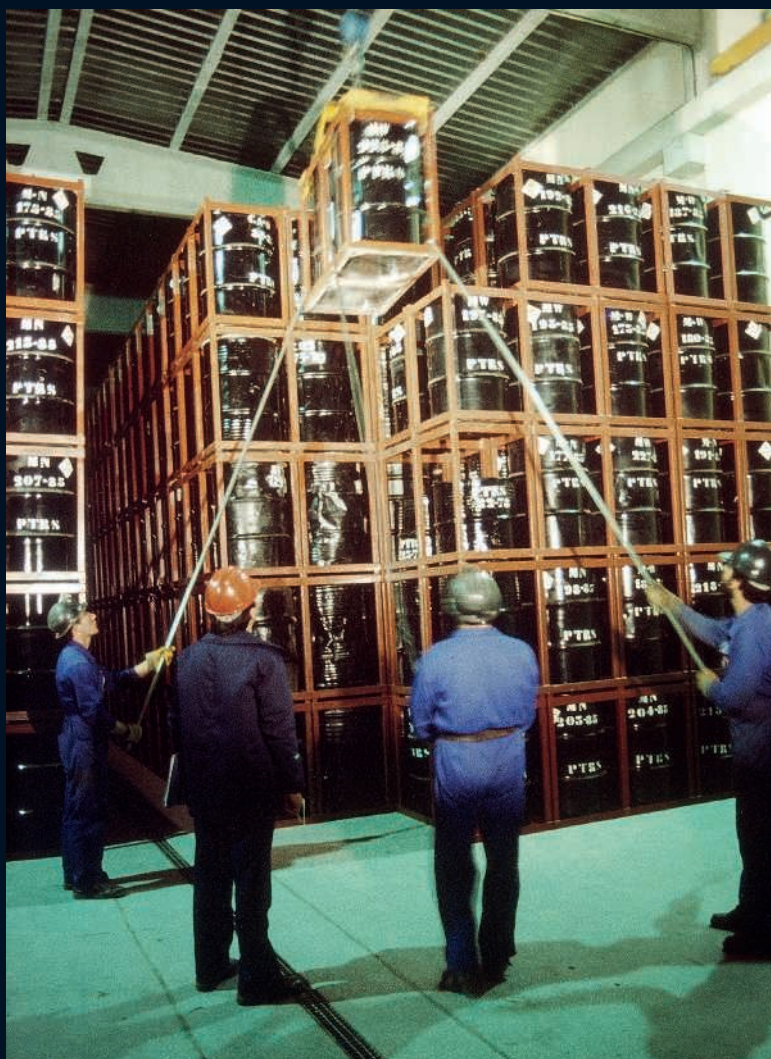
Hasta 1992, los residuos radiactivos de baja y media actividad se almacenaban en los módulos de almacenamiento.
