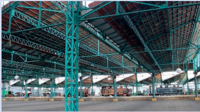
Imagen en la que se aprecian las grandes dimensiones del Almacén y su cubierta de dientes de sierra que permite una gran luminosidad.
