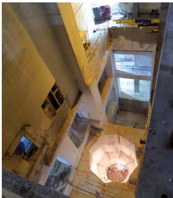
En la imagen superior, estado de las cavidades durante la maniobra de extracción e izado de la vasija del reactor de Zorita, ejecutada en el mes de junio de 2014. Abajo, situación actual, en enero de 2017.
