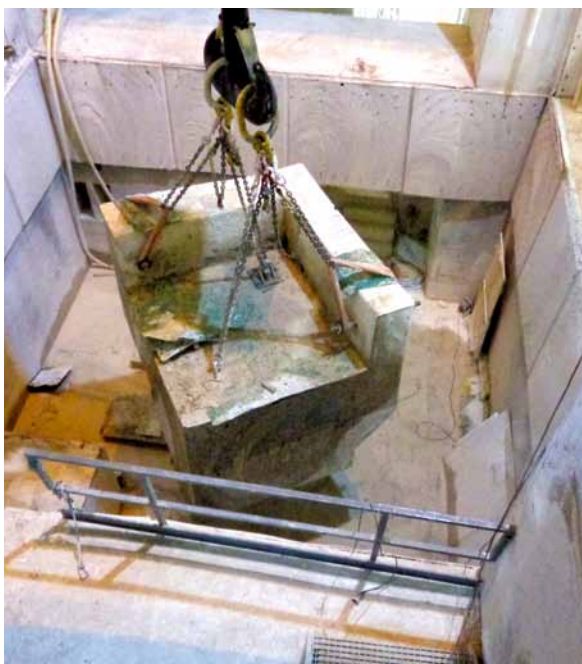
Primeros planos del hueco dejado por la vasija del reactor de Zorita. En la imagen superior, a la derecha, se pueden apreciar los conductos por los que discurrían las ramas fría y caliente del circuito primario.
