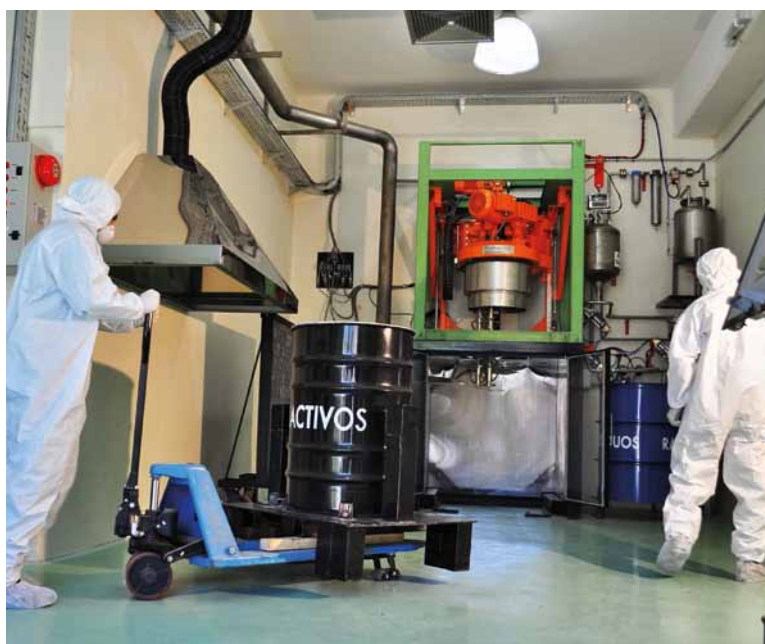
Planta de compactado y cementado de residuos en el Area de Gestión de Ezeiza.
