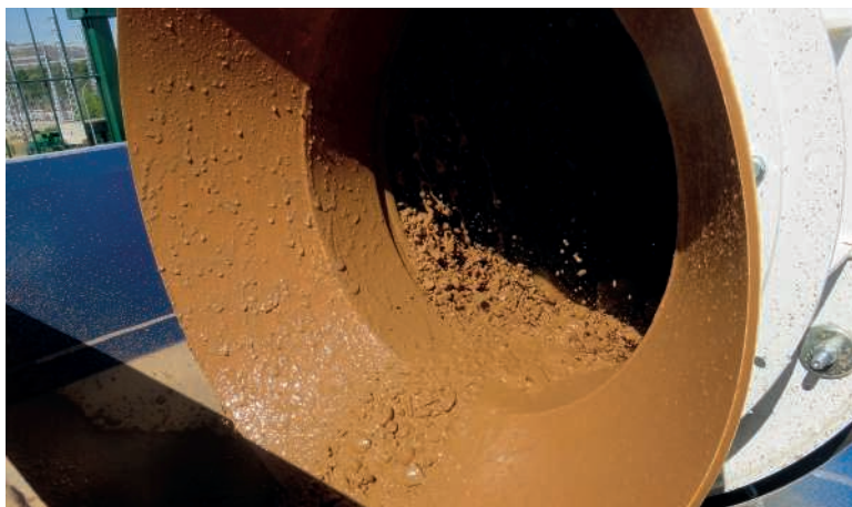
Línea de clasificación granulométrica y separación de gravas. Desde la tolva, se trasladan las tierras, mediante la cinta de alimentación de banda transportadora, hasta el primer equipo de lavado: cilindro de lavado ("tromel"). La mezcla de tierra lavada y agua de lavado se conduce por gravedad a una criba vibrante inclinada que permite clasificar granulométricamente.
