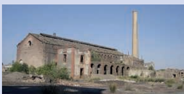
Uno de los edificios del complejo industrial.
