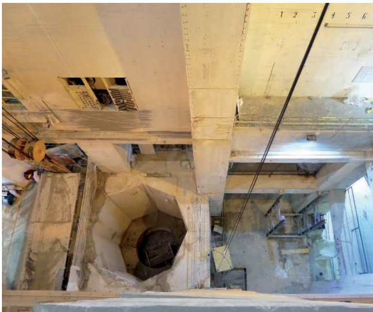
Estado de la cavidad del reactor y del Foso de Combustible Gastado durante la segmentación de la vasija (arriba). Y estado actual de ambas cavidades tras la retirada del blindaje biológico del reactor de Zorita (abajo).
