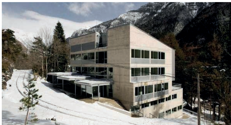
Edificio en superficie del Laboratorio, ubicado en la ladera del monte Tobazo (Pirineos).
