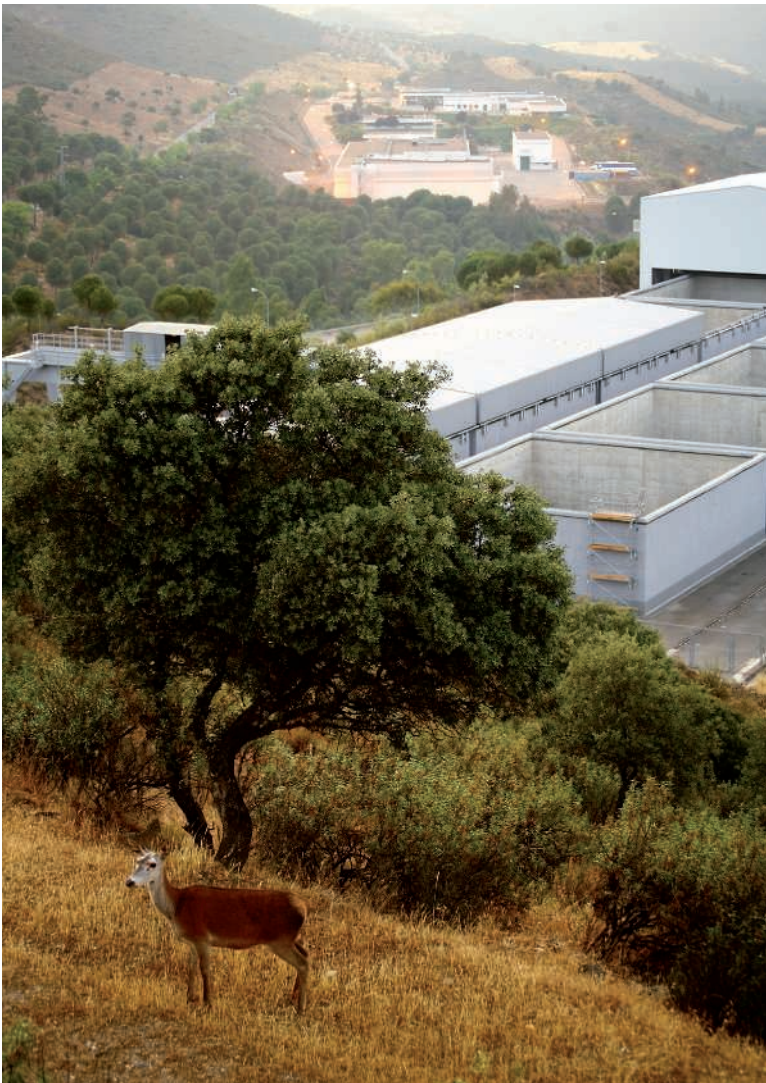
Figura 2. Entorno de la biosfera en las instalaciones de El Cabril.
