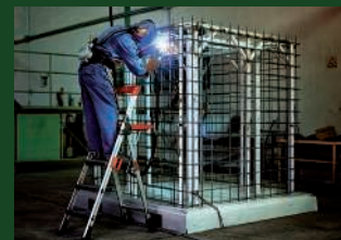
Trabajos de soldadura en la nave de fabricación de contenedores.
