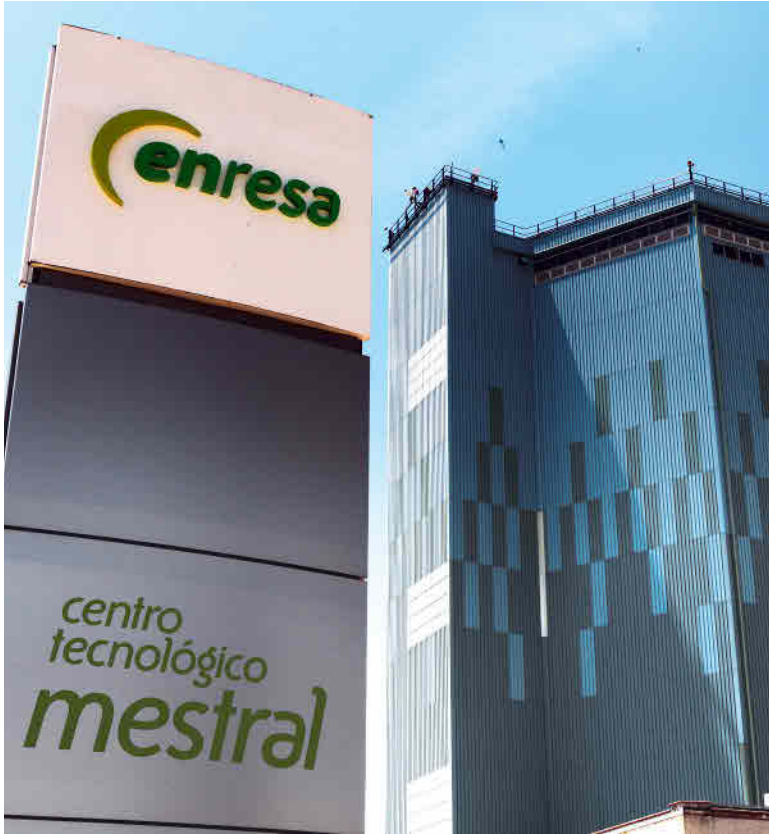
Vista general del cajón del reactor de Vandellós I.
