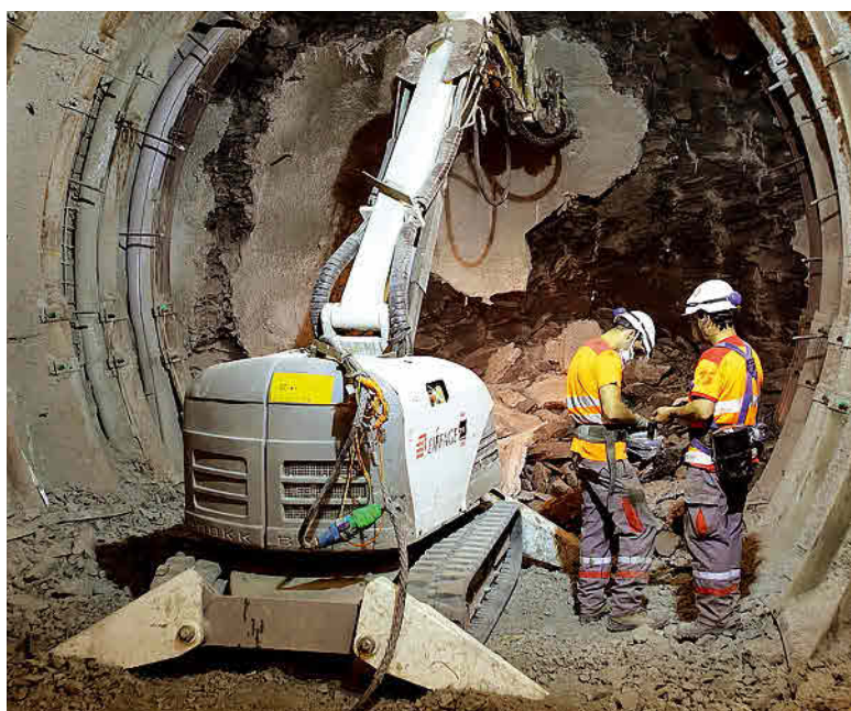
Trabajos de tunelación en el laboratorio de Bure.
