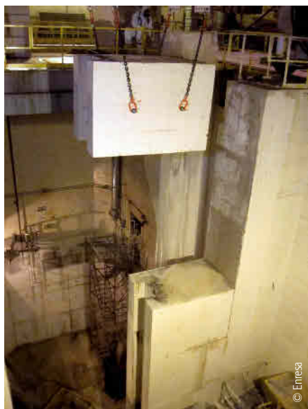
Detalle de la retirada de uno de los bloques de hormigón de la pared de separación de cavidades. Pesa 17 toneladas y tiene un volumen de 7 metros cúbicos.
