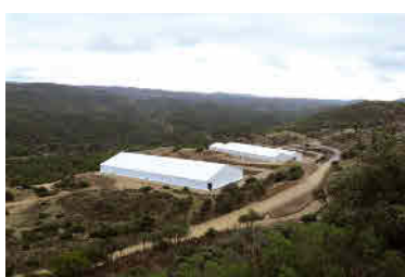
Avance de las obras de la celda 30.
