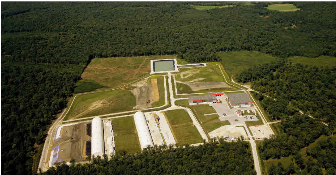
Vista aérea de la instalación de almacenamiento de residuos de muy baja actividad en Morvilliers. La instalación abarca una superficie de 45 hectáreas. En este centro se almacenan los residuos de muy baja actividad provenientes de instalaciones nucleares y radiactivas.
