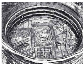
Imágenes de la etapa de construcción de la central nuclear José Cabrera, a mediados de la década de los 60. Se puede apreciar la envergadura de las estructuras de los muros de hormigón armado sobre las que se está trabajando ahora para su retirada.
