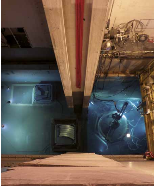
Estado de la cavidad de recarga y del foso de combustible gastado durante los trabajos de segmentación bajo el agua de la vasija del reactor.
