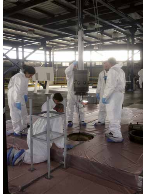
Trabajos de preparación del cajón del reactor para la prueba de estanqueidad.
