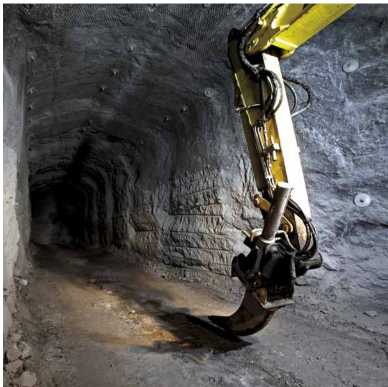
Posiva completó los trabajos de excavación para el túnel de acceso y salas técnicas en 2012, año en el que presentó la solicitud de licencia de construcción para la instalación.
