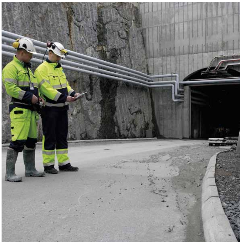
Acceso a las instalaciones subterráneas de Onkalo.
