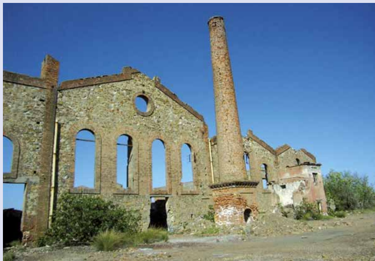
Estado que presentaba el edificio antes de someterlo al proceso de rehabilitación.
