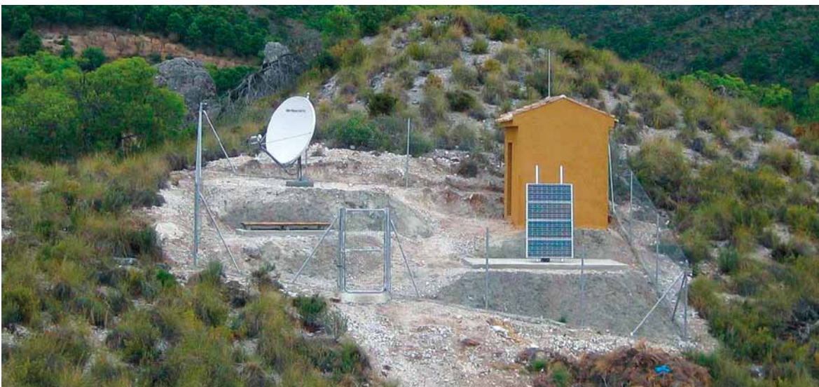
Una de las estaciones fijas con las que cuenta la Red Sísmica Nacional y que se ubican en lugares recónditos para que la captación de datos no se vea interferida por ruido ambiental o actividad humana.
