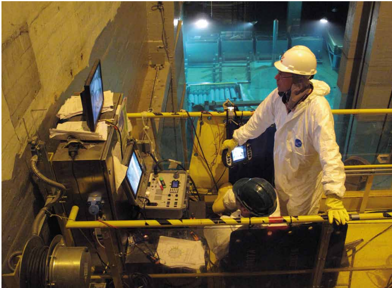
Puesto de control y ejecución de los trabajos de corte.
