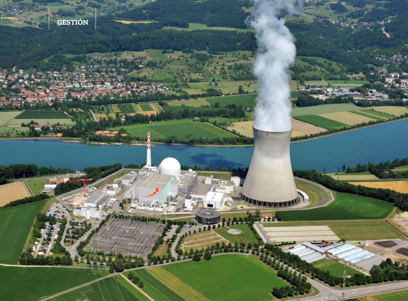
Vista aérea de la central nuclear de Leibstadt.
