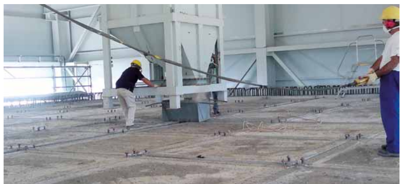
Vertido de la grava de relleno en la cruceta central de una celda de almacenamiento.
