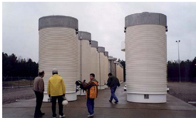
Almacenamiento temporal de combustible gastado en la central nuclear de Surry (Virginia, Estados Unidos). / ARCHIVO ENRESA
