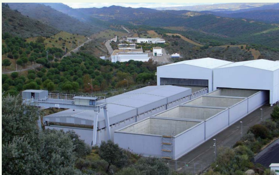
Instalaciones de El Cabril (Córdoba). / ENRESA
