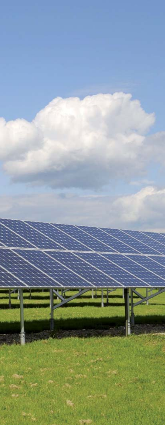
A la izquierda, un huerto solar en operación. Cuando finalice su vida útil, los paneles se retirarán y reciclarán para obtener silicio, aluminio y vidrio, entre otros materiales.
