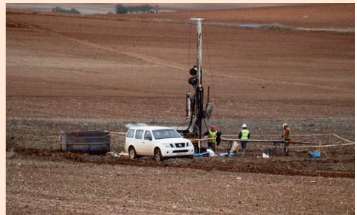
Sondeos en los terrenos del futuro ATC.
