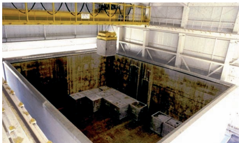
Figura 2. Proceso de llenado de una estructura de almacenamiento.
