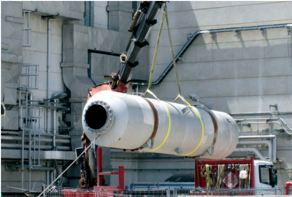
Trabajos de desmantelamiento en la central José Cabrera, en Almonacid (Guadalajara).
