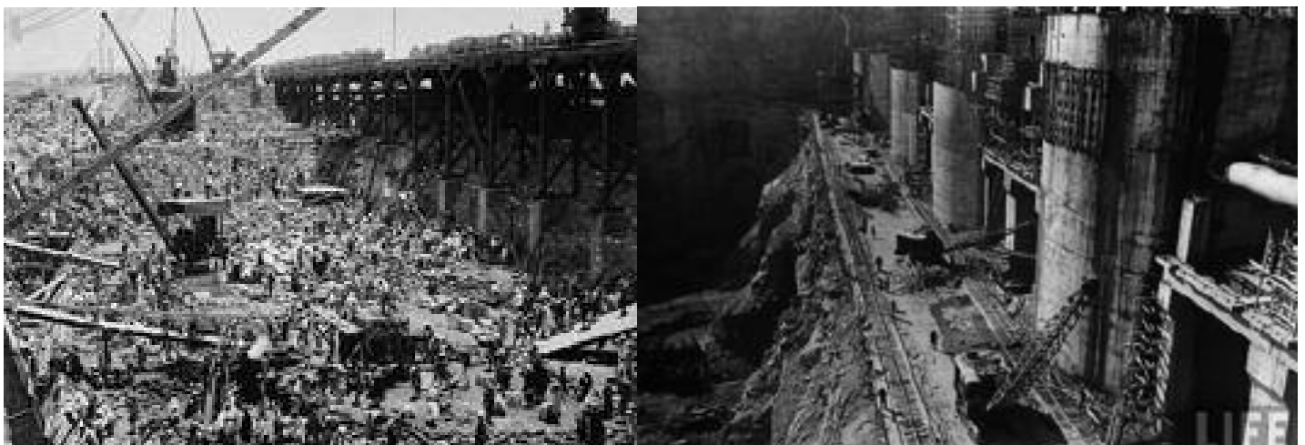
Obras de construcción de la presa, que comenzaron en 1960 y acabaron diez años después.
