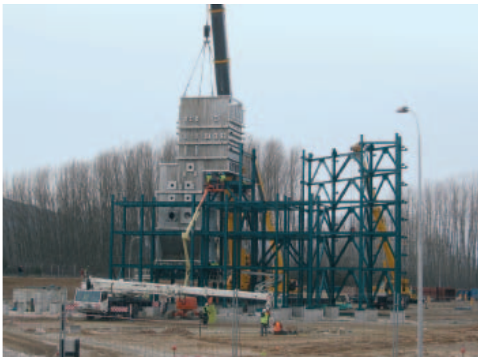
Obras de la primera planta piloto CAC en Cubillos del Sil (León).
