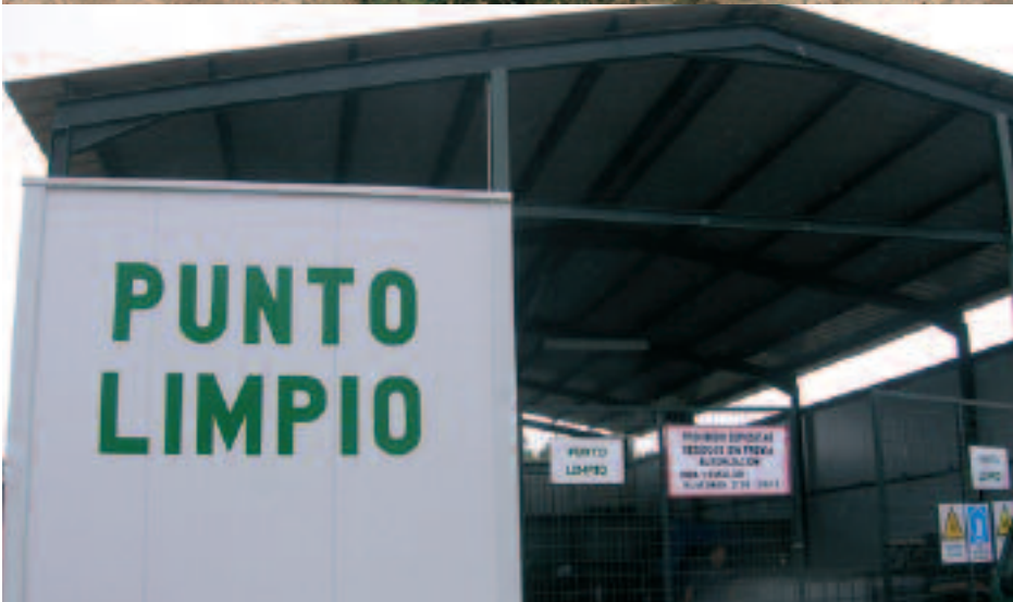
Arriba, vertedero clausurado en Baleares. Sobre estas líneas, punto limpio de un acuartelamiento.
