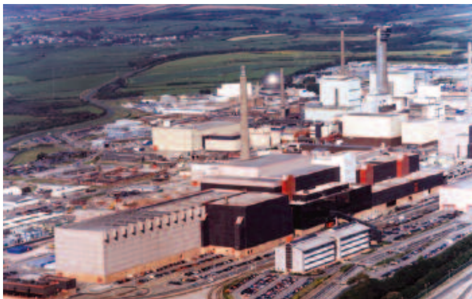
Planta Thorp, donde se reprocesan combustibles gastados de tipo óxido. A la izquierda, contenedores para el almacenamiento de residuos vitrificados.
