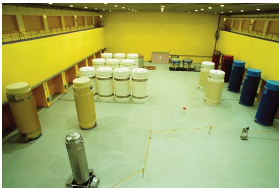
La instalación para residuos de alta actividad y combustible gastado tiene capacidad para almacenar 200 contenedores de doble uso.
