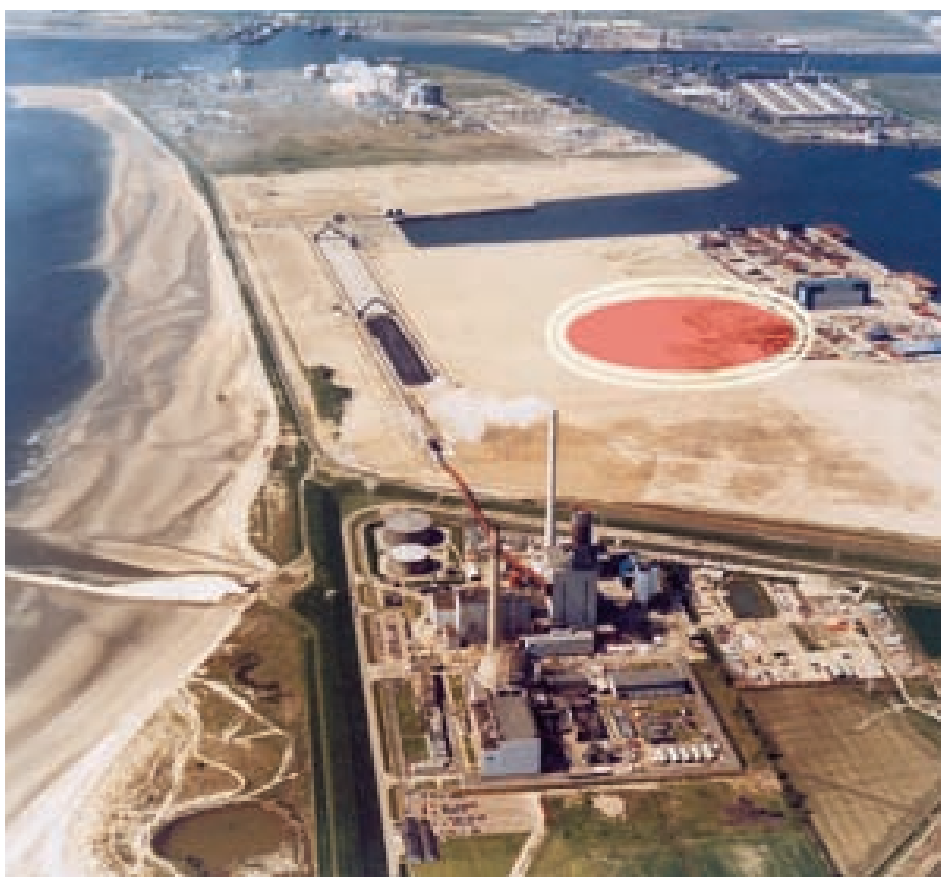
Emplazamiento de HABOG en el municipio de Borsselle, antes de su construcción.
