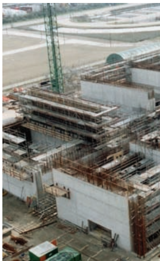
Construcción del Almacén Temporal Centralizado holandés.
