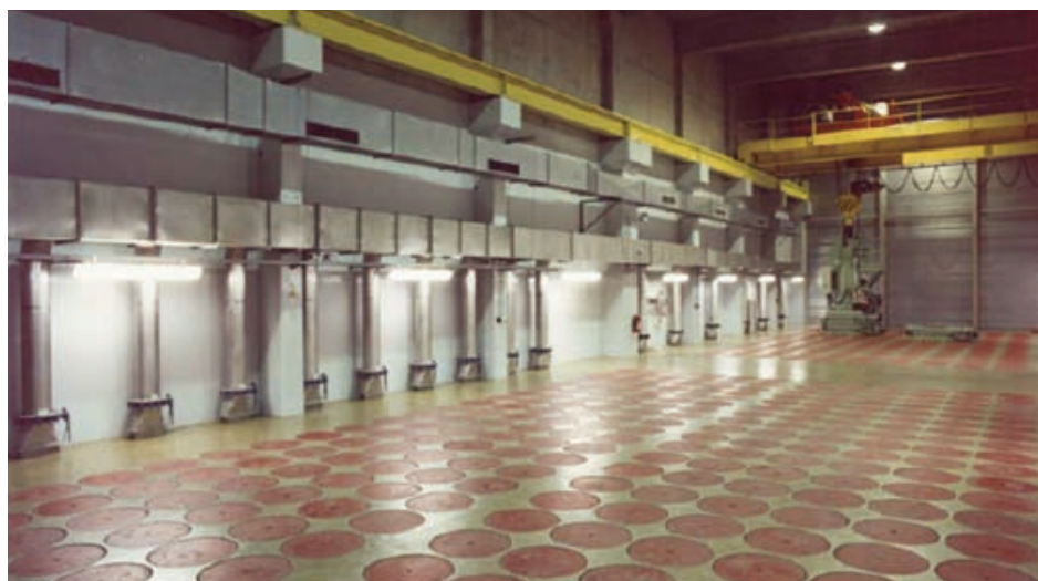
Almacenamiento de combustible gastado en contenedor en la central nuclear de Doel. A la derecha, bóveda del ATC de Dessel destinada al almacenamiento de vidrios procedentes del reproceso en la planta de Eurochemic.
