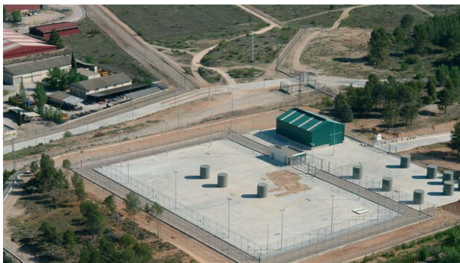
Panorámica del almacén temporal de combustible de la central nuclear José Cabrera.
