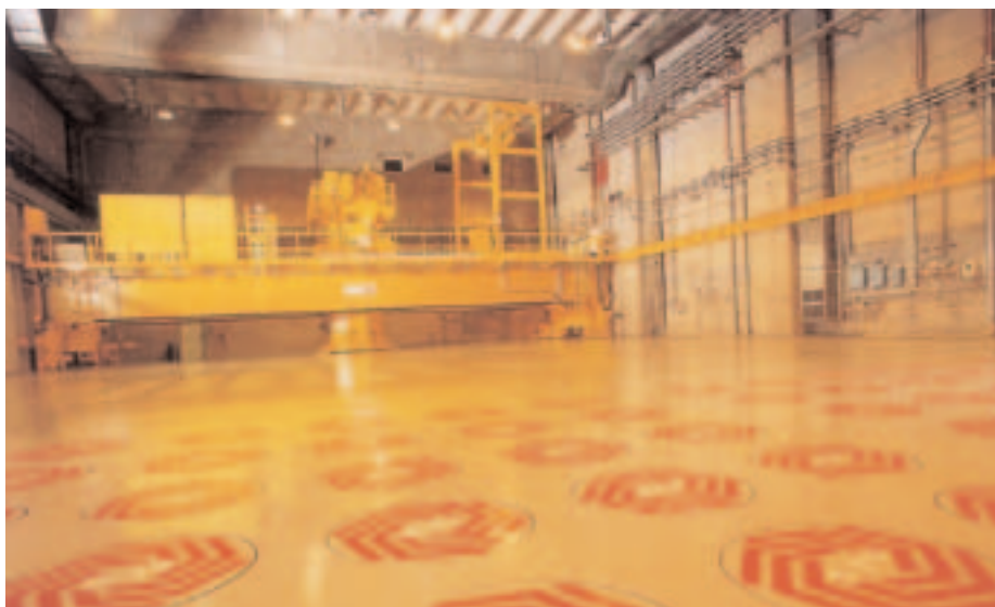
Instalaciones de almacenamiento de combustible gastado de La Hague (Francia)
