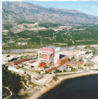
Desmantelamiento de la C.N.Vandellós I.
