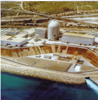
Apoyo a la explotación de C.N.Ascó I y II y C.N.Vandellós II.
