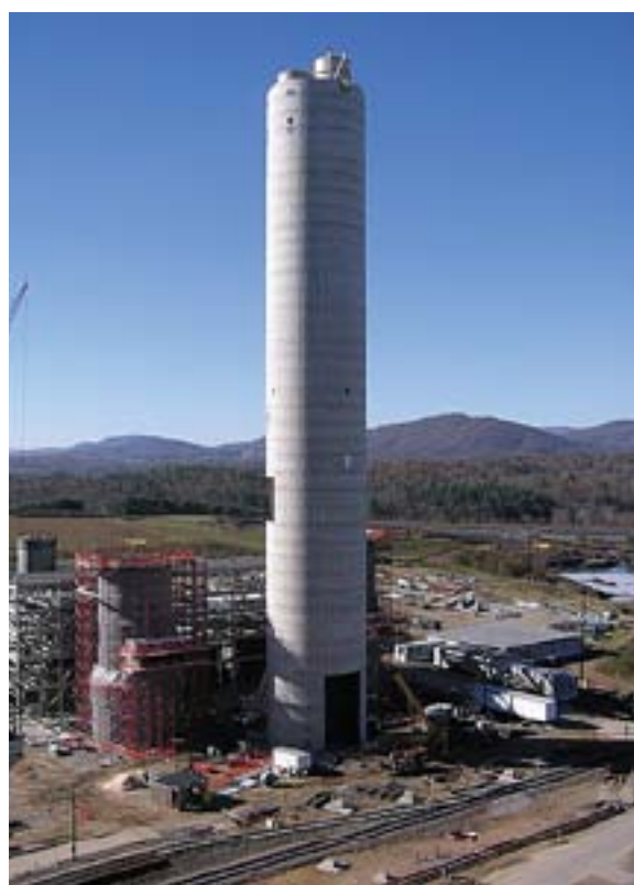
A la izquierda, alzado del proyecto de una planta gasificadora de carbón en Illinois (Estados Unidos). Sobre estas líneas, construcción de una chimenea con lavado de gases en una central térmica.
