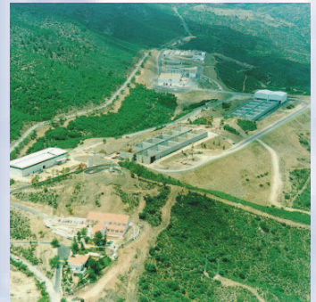
Centro de Almacenamiento de Residuos de Baja y Media Actividad en El Cabril.
