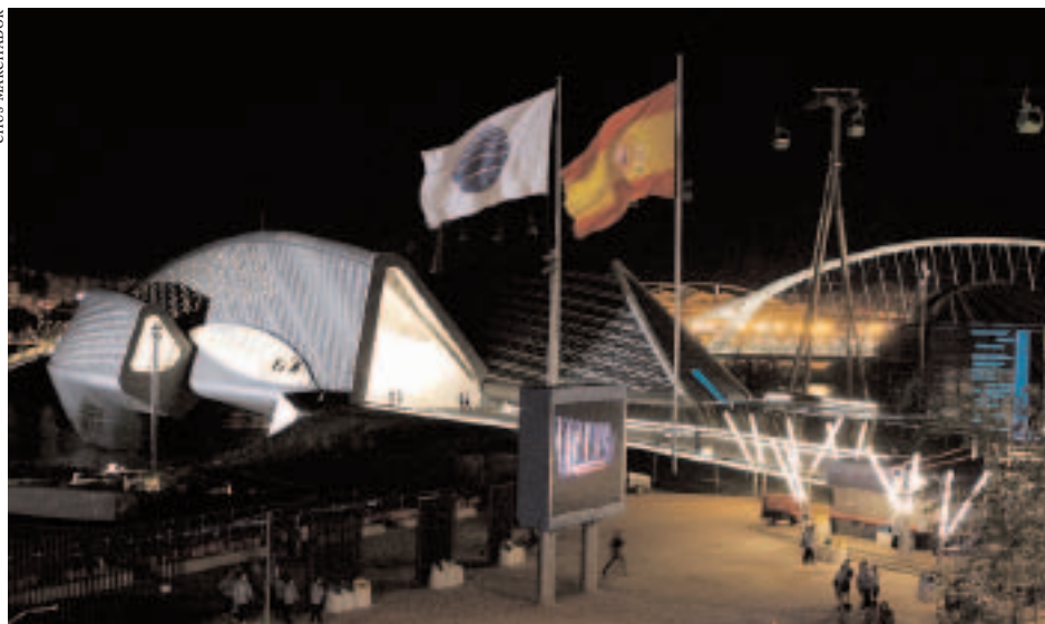
Vista del Pabellón Puente (izquierda) y de la pasarela peatonal de Manterola (derecha).
