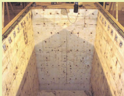
Piscina del reactor tras la retirada del recubrimiento.
