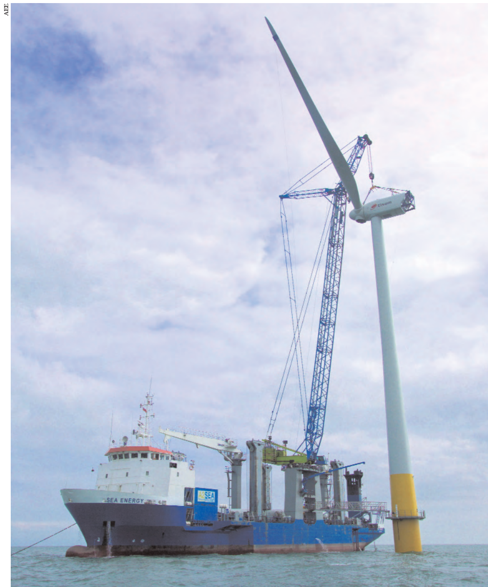
Instalación de un aerogenerador marino.
