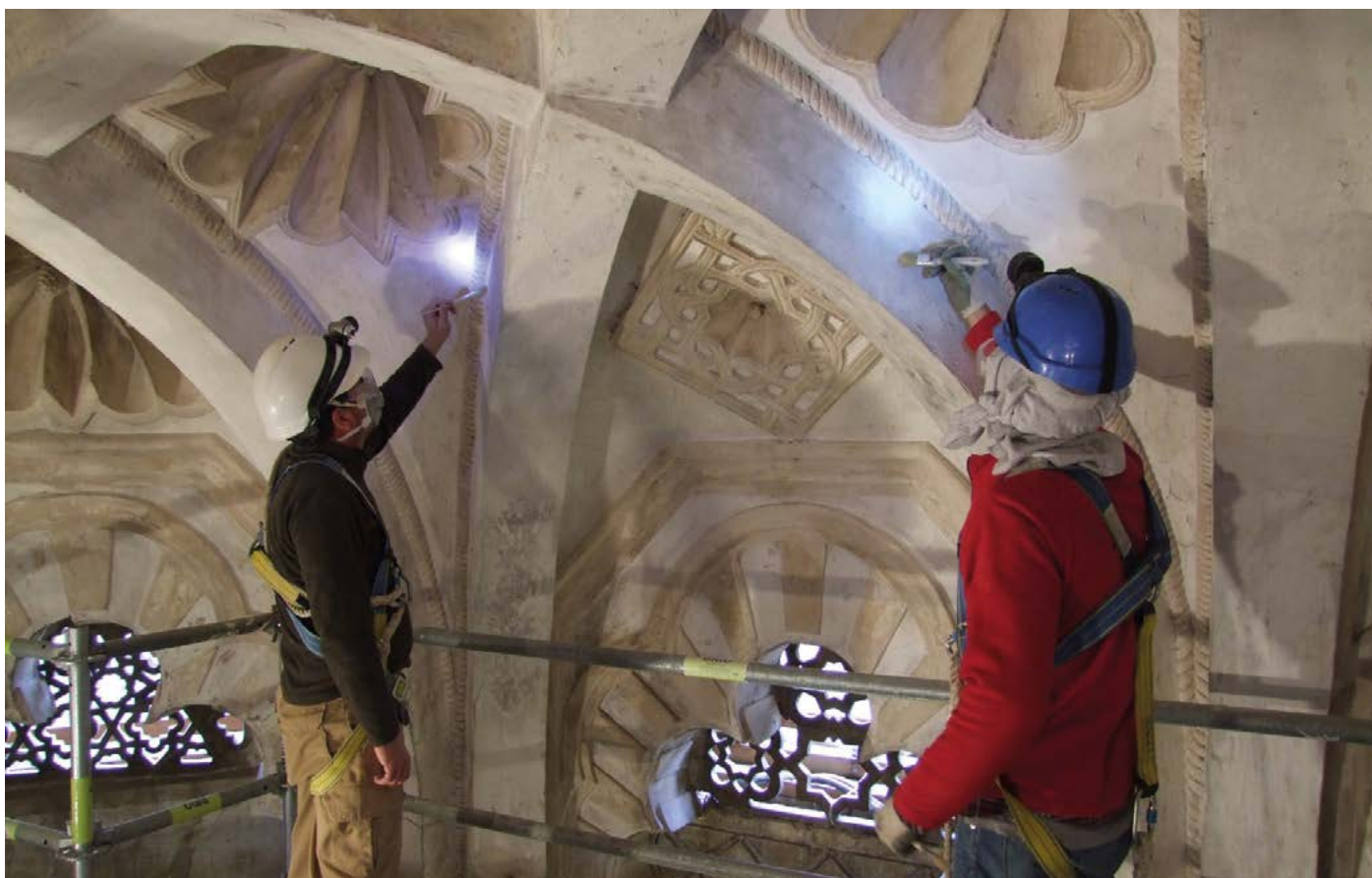
Restauración de la macsura
