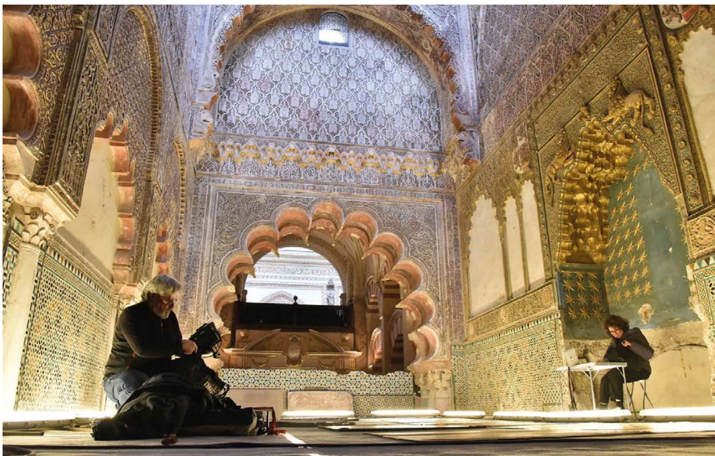
Trabajos de restauración de la Capilla Real
