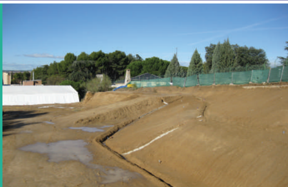
Área Montecillo tras su restauración.
