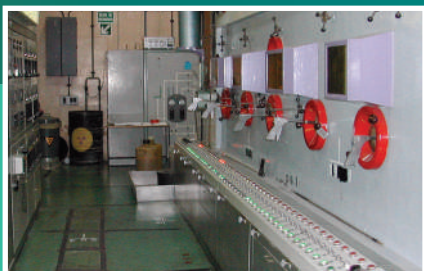
Planta de reproceso antes del desmantelamiento
