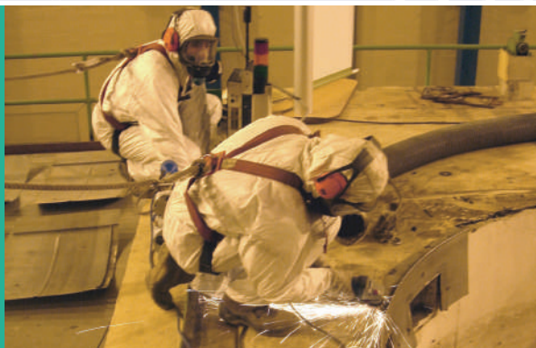
Trabajos de desmantelamiento
