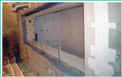
Planta de reproceso durante el desmantelamiento
