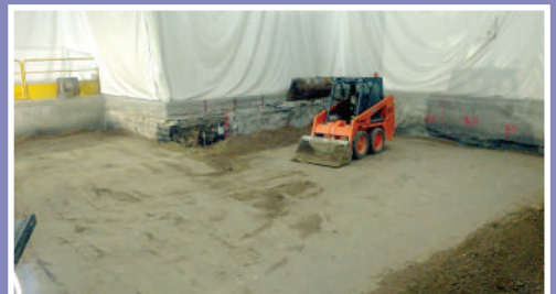
Relleno excavación
