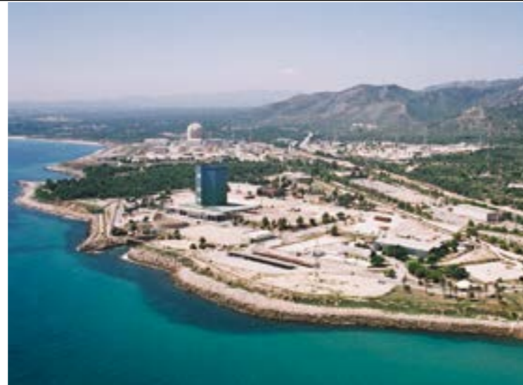
Estructura de protección del reactor en color azul para integrarse en el entorno marino.
