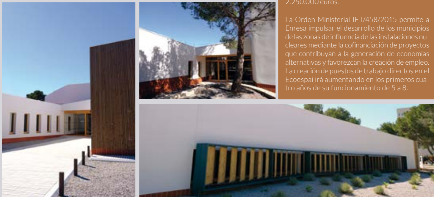
La forma irregular del Ecoespai responde a los usos del edificio mientras se adapta a la orografía del terreno y permite la transpiración de los materiales de su estructura.
