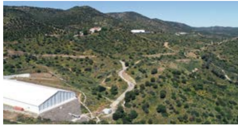
Área de almacenamiento de residuos de muy baja actividad del C.A. El Cabril.
