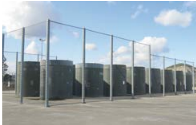
Desde arriba: piscina de combustible gastado de la C.N.-Santa M a de Garoña y equipo Box Counter instalado en la central. Abajo, el Almacén Temporal Individualizado de la CN José Cabrera.
