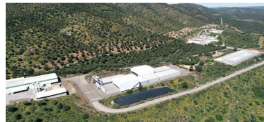
Vista del C.A. El Cabril con las plataformas para residuos de baja y media actividad en primer término.
