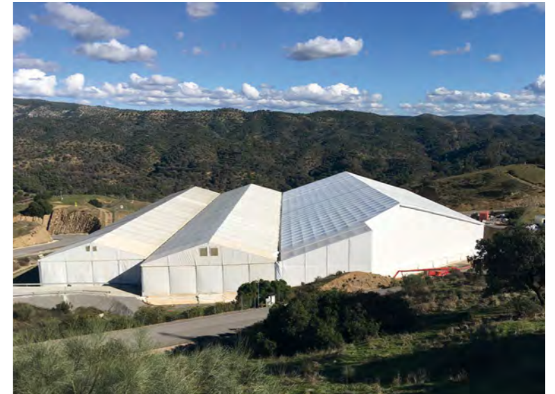
Celda 29 para el almacenamiento de residuos de muy baja actividad.
