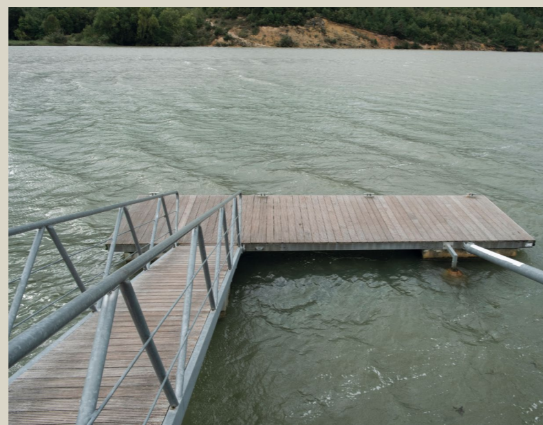
Detalle del muelle flotante del embarcadero.
