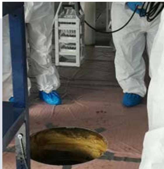
... Bastidor con los juegos de probetas en uno de los pozos de la losa del reactor.
