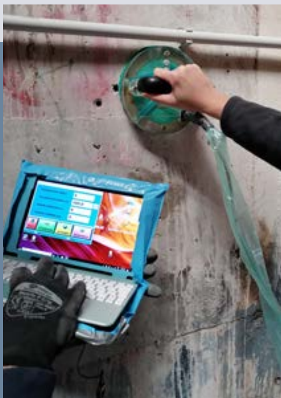
... Medida de resistencia eléctrica en la armadura del cajón del reactor.
