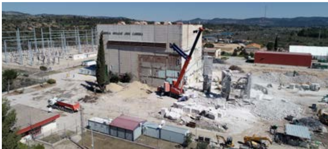
Últimos trabajos de demolición del Edificio de Contención.
