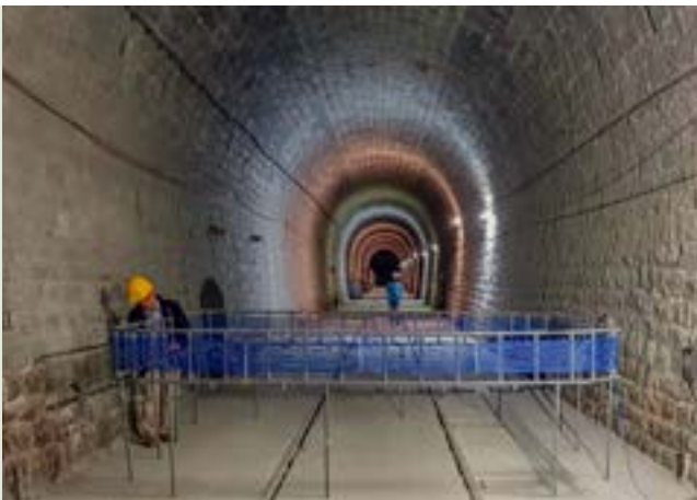
Componentes de un sistema de monitorización inalámbrico instalado en el Laboratorio Subterráneo de Tournemire (Francia).
