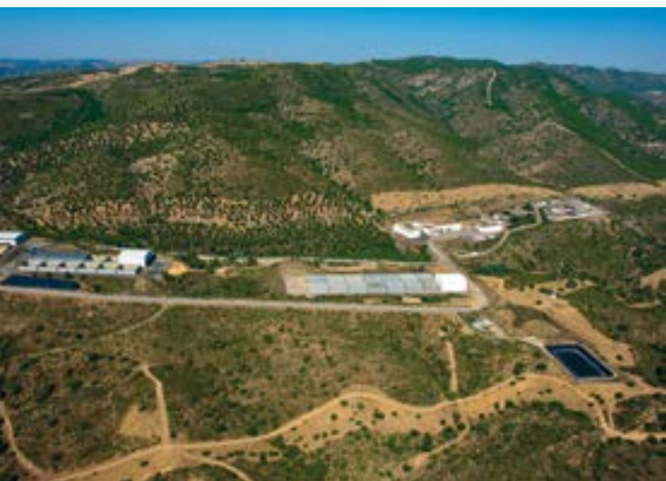
Vista de la finca El Cabril. En el centro de la foto se destaca la zona industrial.
