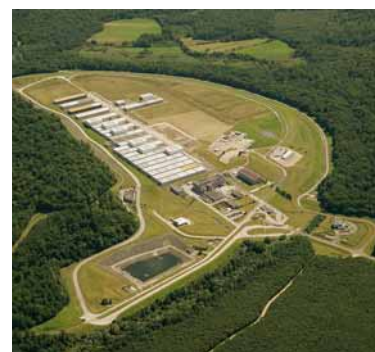
Vista aérea de la instalación de almacenamiento de RBMA de Andra en L'Aube.
