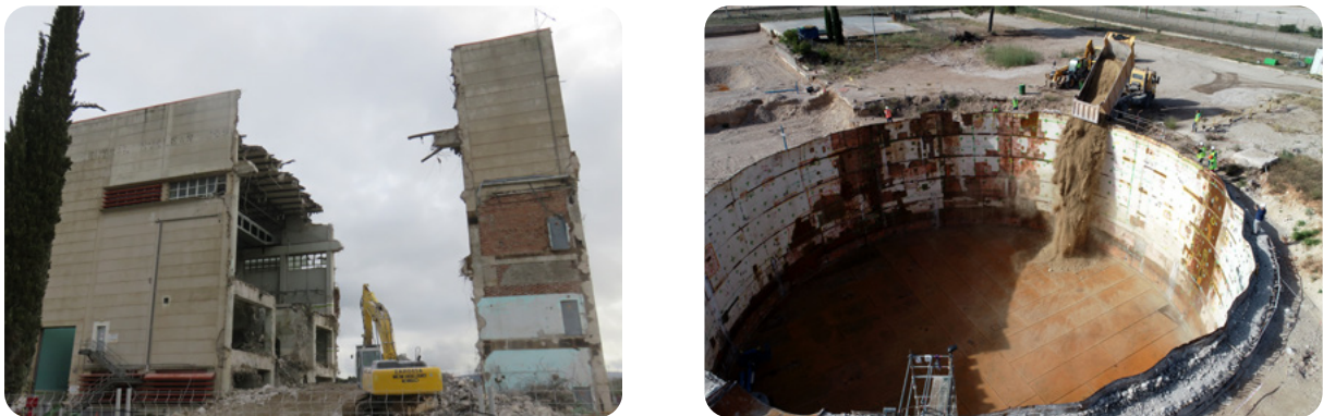
Figura 3-15: Diferentes fases en el desmantelamiento de la CN José Cabrera
