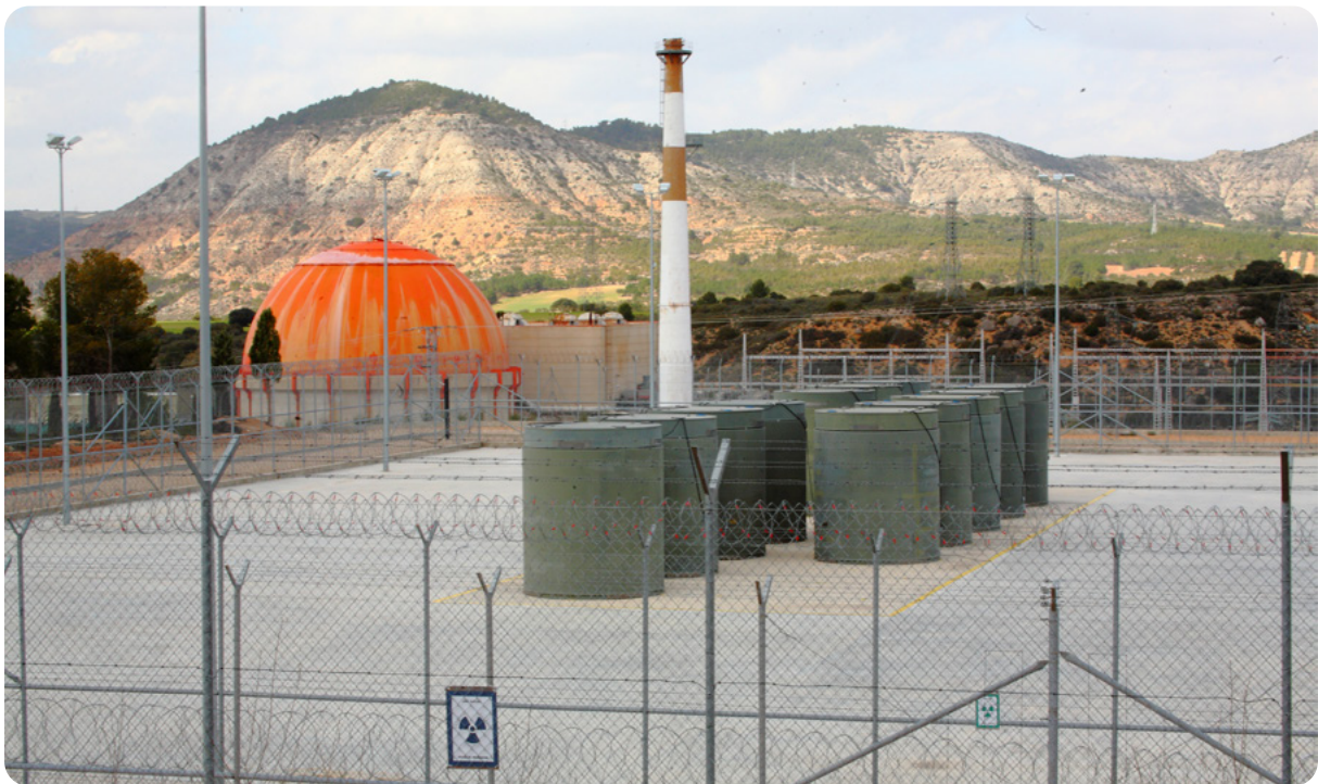
Figura 4-5: Vista general del ATI de la CN José Cabrera
