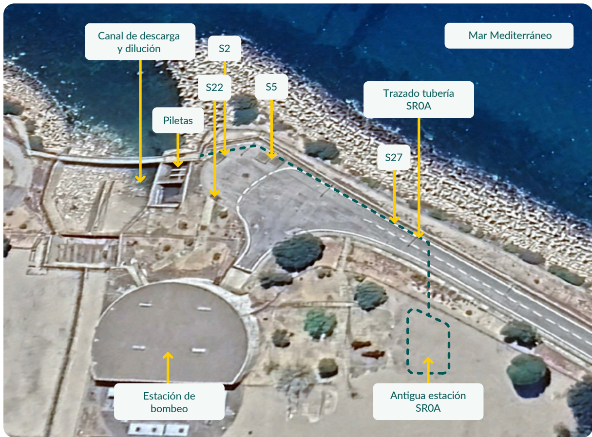
Figura 5-30: Vista de la zona SROA
