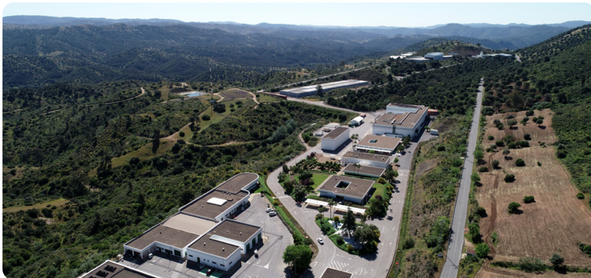
Figura 3-2: Vista aérea del Centro de Almacenamiento de El Cabril (C.A. El Cabril)
