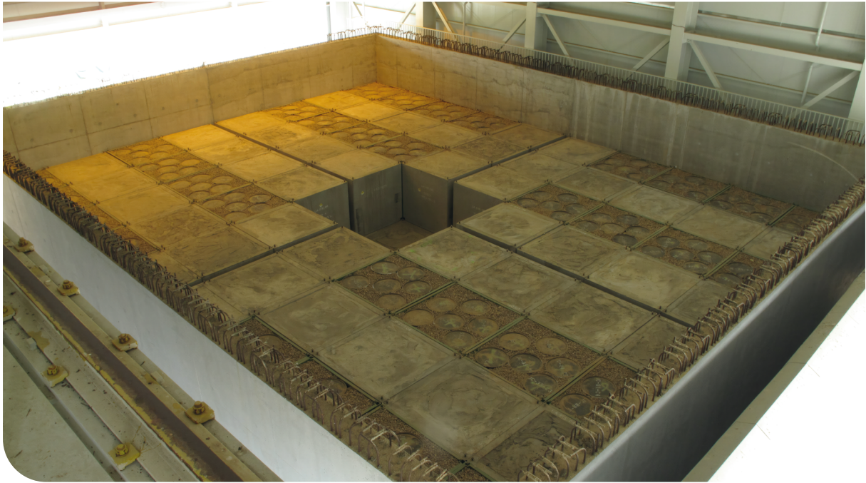
Figura 11. Celda de almacenamiento de RBMA
