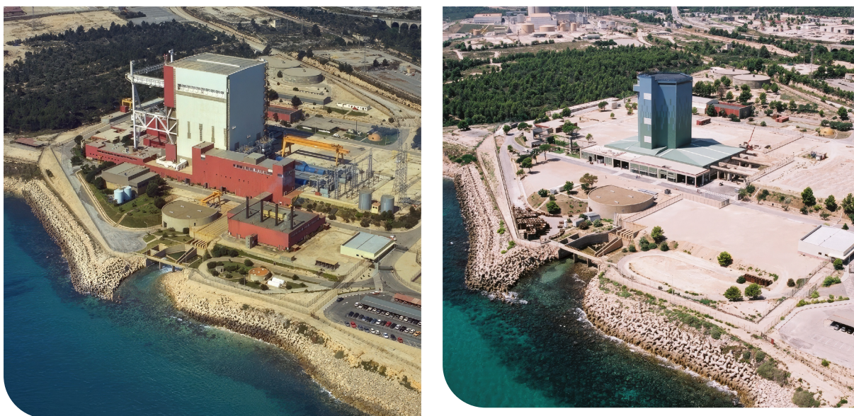
Figura 20. Aspecto del emplazamiento de la C.N. Vandellós I antes y después del desmantelamiento parcial
