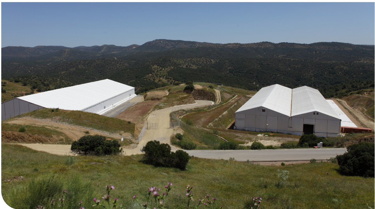
Figura 12. Instalación complementaria para el almacenamiento de RBBA
