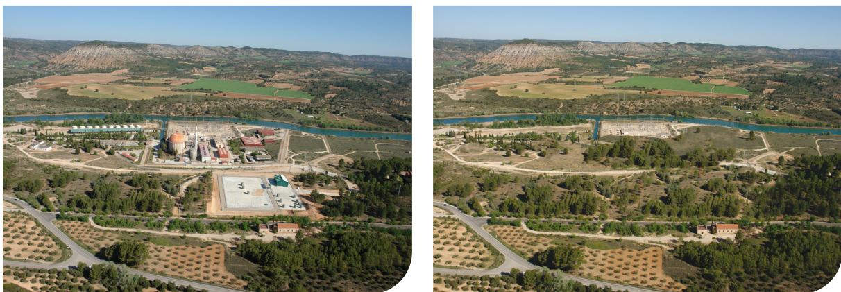
Figura 21. Aspecto del desmantelamiento de C.N. José Cabrera: antes y después (figurado) del desmantelamiento total
