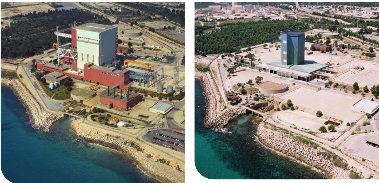
Figura 20. Aspecto del emplazamiento de la C.N. Vandellós I antes y después del desmantelamiento parcial
