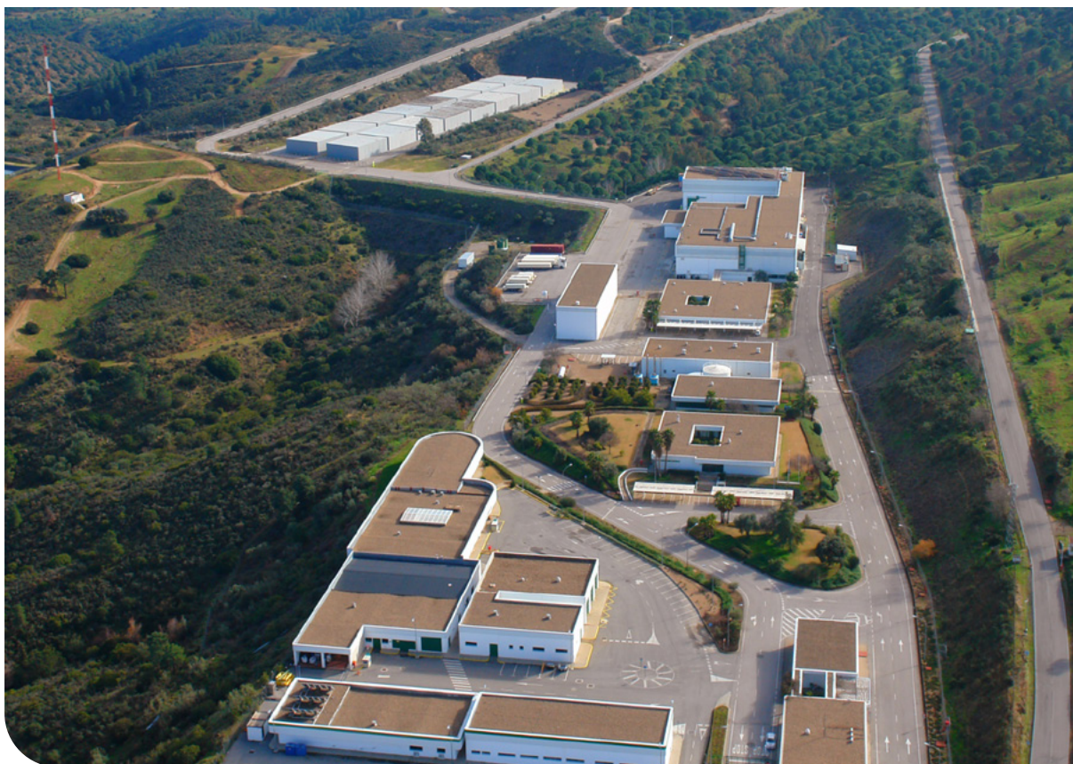
Figura 9. Vista aérea de la instalación de C.A. El Cabril
