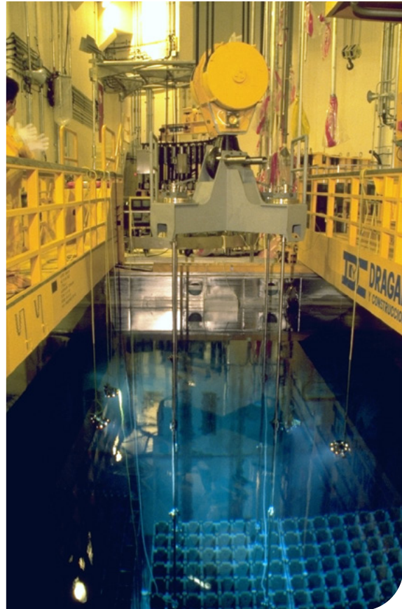
Figura 13. Piscina de almacenamiento de CG
