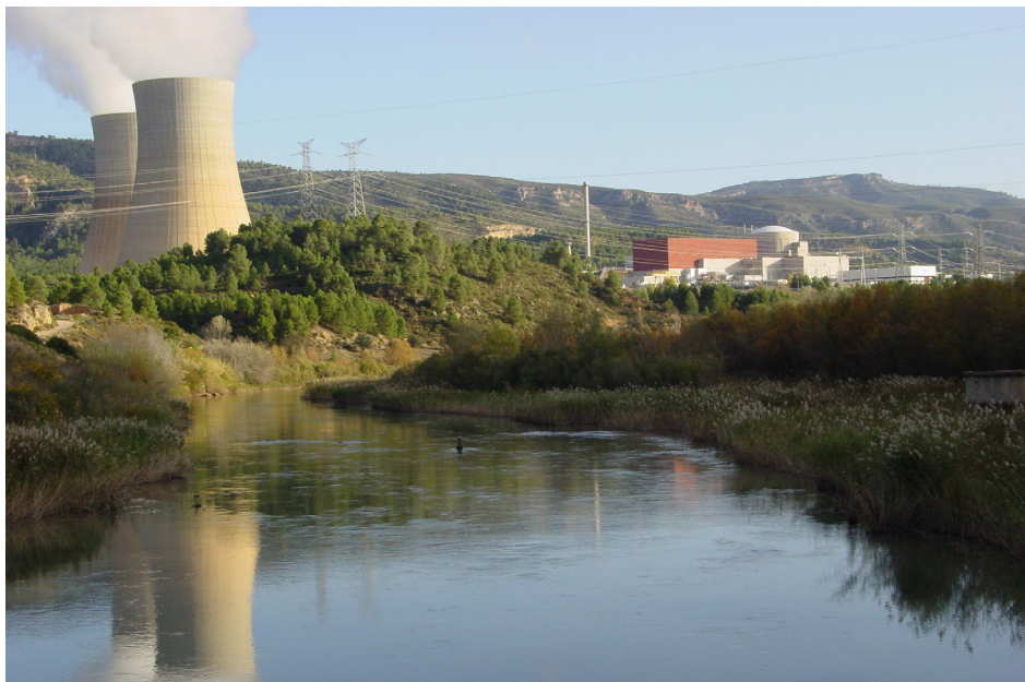
Vista de la Central Nuclear Cofrentes (Valencia).
